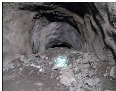
Relleno de roca. Fuente: OSINERGMIN
