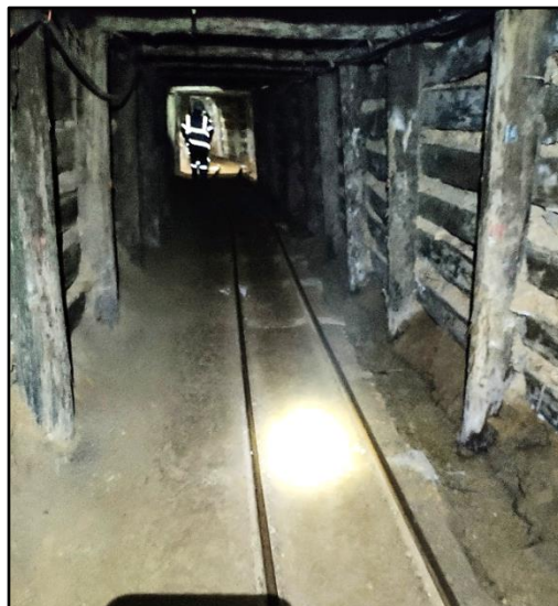
Cuneta limpia construida en el límite lateral de la galería, de manera que el piso de la labor se conserva razonablemente seca
