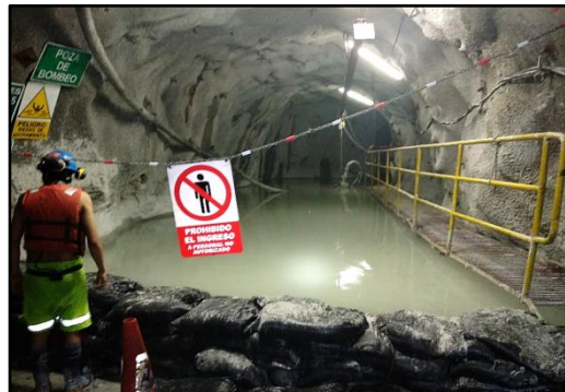
Cámara con diseño seguro de bombeo, con iluminación, plataforma y barandas para acceder hasta la bomba.
