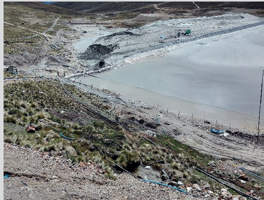
Derrame de relaves - Perú 2018.
