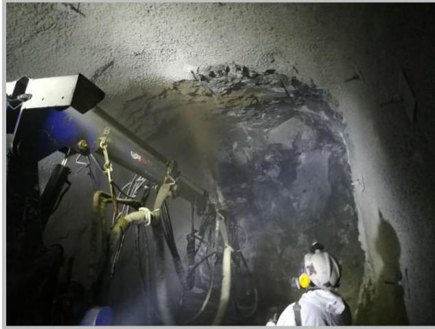
CONSTRUCCIÓN DE TUNELES
