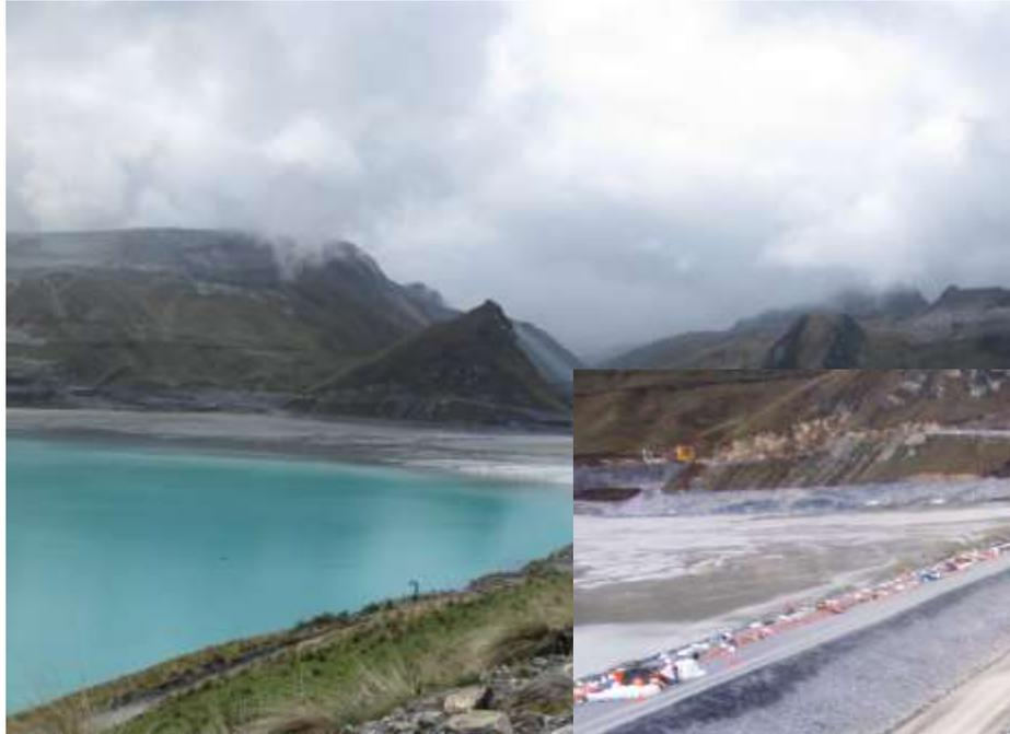
Vista panorámica del vaso de la relavera, en la que se aprecia el agua decantada distante del cuerpo de presa y formación de playa sobre el talud aguas arriba de la presa.
