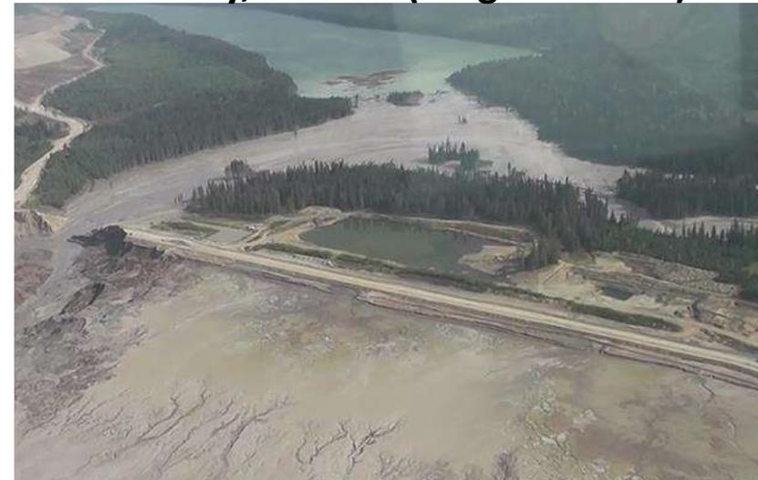
Vaciamiento de 4,5 millones m<sup>3</sup> de relaves y 10 Mm m<sup>3</sup> de agua. Ruptura fue por falla de la fundación del "terraplén", que ocurrió en una capa glaciolacustre del suelo de fundación
