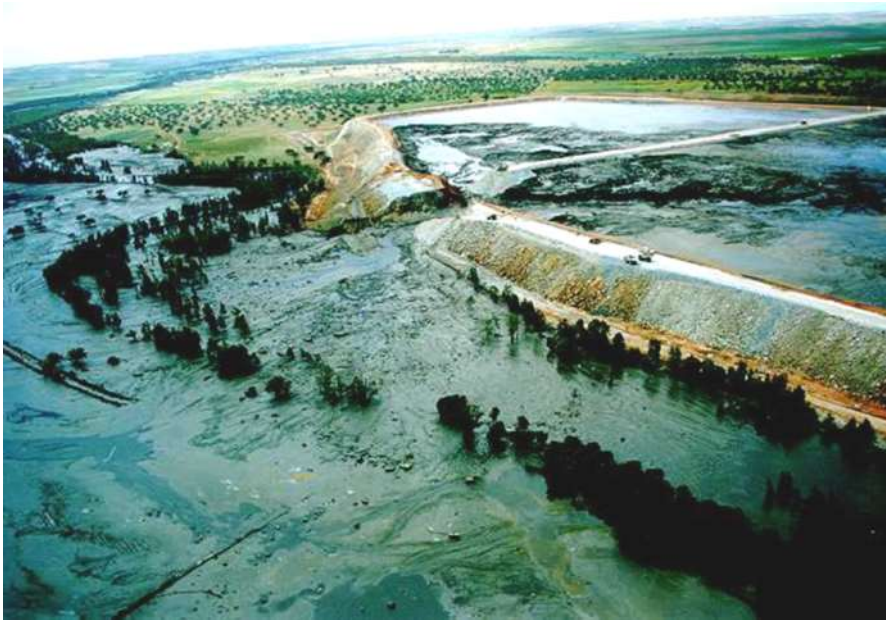
Los Frailes, Spain - 1998
