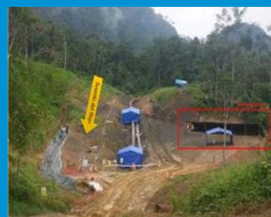
Km.440+781: Movimiento de tierras v control de erosión
