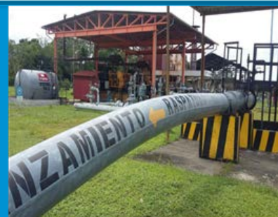
Trampa de lanzamiento Estación Andoas
