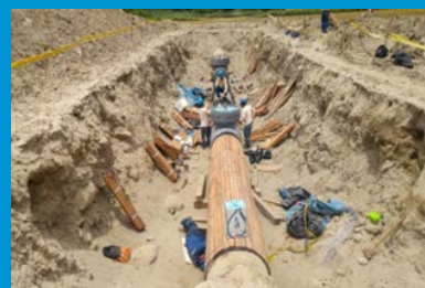
Km.558+794: Protección del revestimiento
