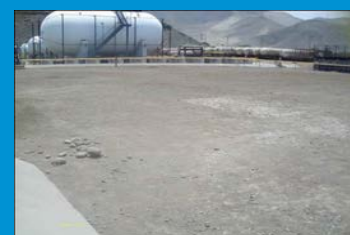
Zona donde se construirá esfera de GLP
