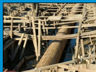
Km.504, colocación de pórticos de madera.
