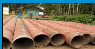
Tubería de reemplazo en dicho sector
