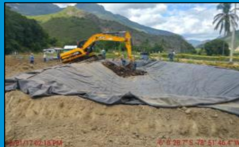
Construcción de poza para recuperación de tierra contaminada, Km.570+187.7
