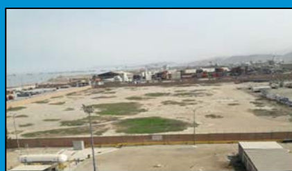
Terreno donde se construirán las esferas
