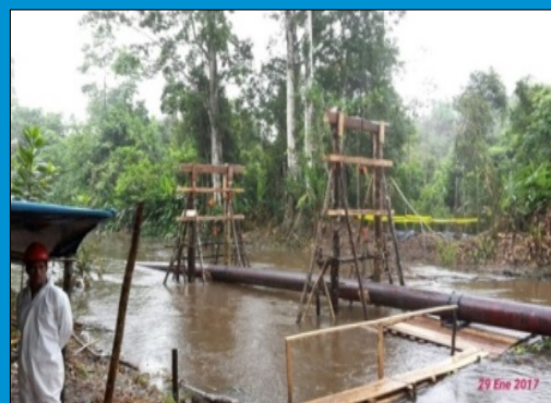
Km.15+300, tubería suspendida con pórticos de madera.
