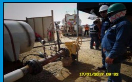
Cabezal de prueba (Punto de inicio) para el nuevo gasoducto de 6"
