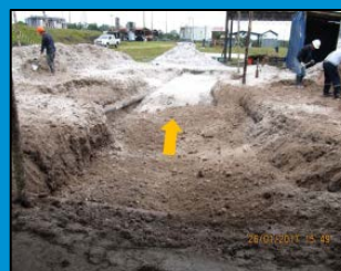
Personal INMAC, cubriendo la zona intervenida
