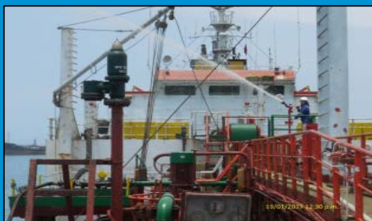
Vista de la prueba al sistema contraincendios del B/T Transgas
