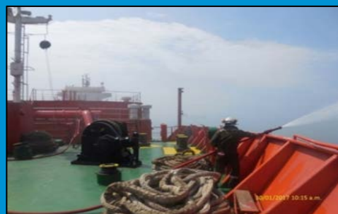
Vista de la prueba al sistema contraincendios del B/T Alorca
