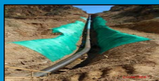
Trabajos de excavación en el Km. 620
