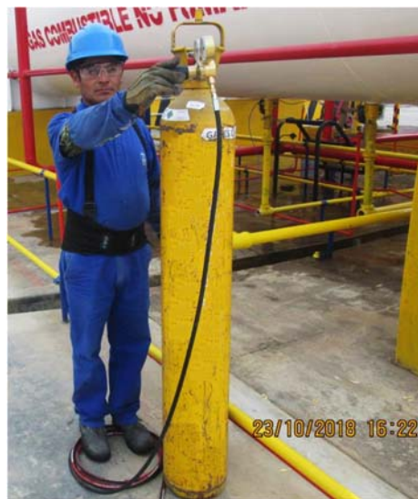
Gas inerte utilizado en prueba de hermeticidad de tuberías de GLP. Personal encargado con el equipo de protección personal.
