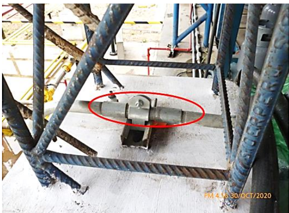
Fig. 11.9: Instalación de uniones no listadas en áreas clasificadas.
