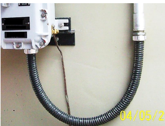
Fig 11.10: Conector flexible plástico unido a un envoltorio a prueba de explosión.
