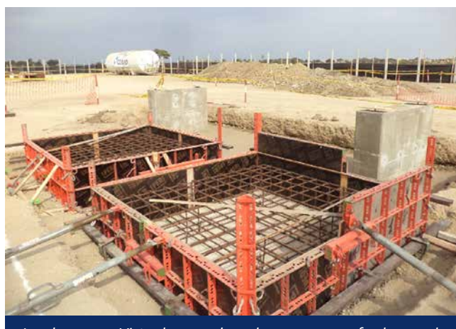
Lambayeque: Vista de armadura de acero y encofrado para la cimentación de vaporizadores
