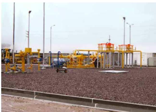
Vista del avance de la construcción del City Gate en Ayacucho
