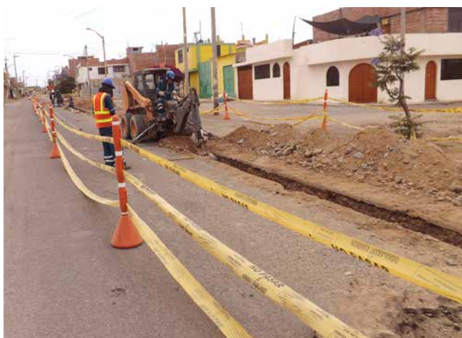
Tacna: Vista de cimientos del muro perimetral de la estación
