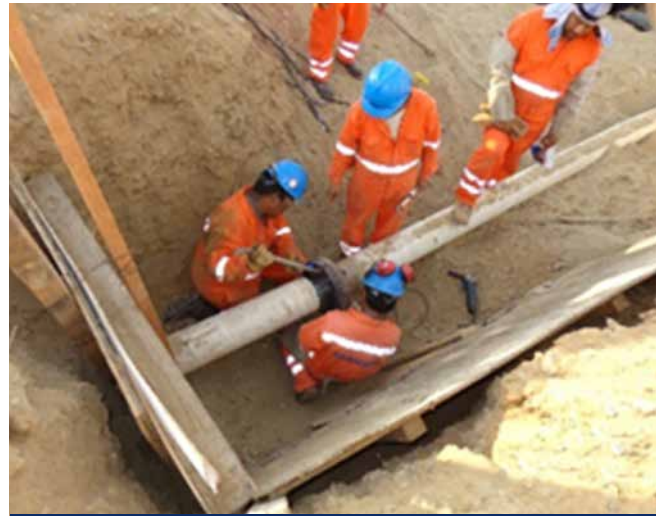
Venteo operativo y realización de unión soldada tramo de ducto que será enterrado
