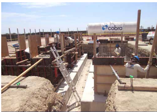
Chiclayo: Encofrado de zapatas para los vaporizadores
