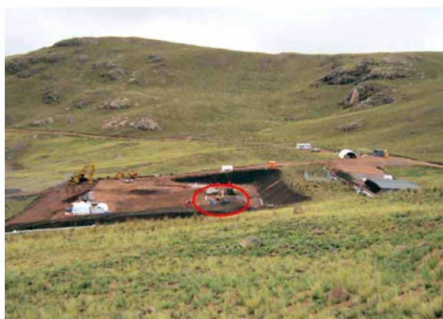
Vista del avance de la construcción de la Derivación KP-277
