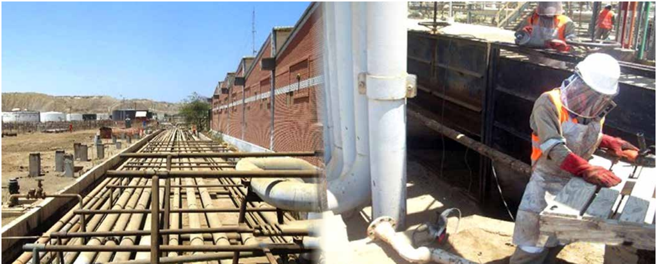
Visita de sensibilización con actividades por el FEN - Vista de trabajos de mantenimiento a compuerta de zona de drenaje de la Refinería Talara
