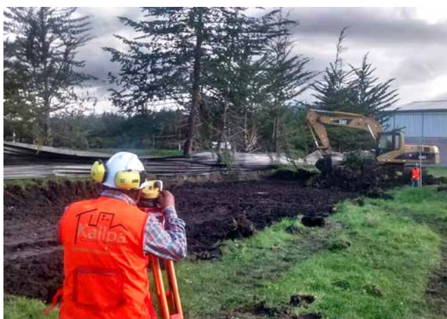
Cajamarca: Topografía y excavación de terreno
