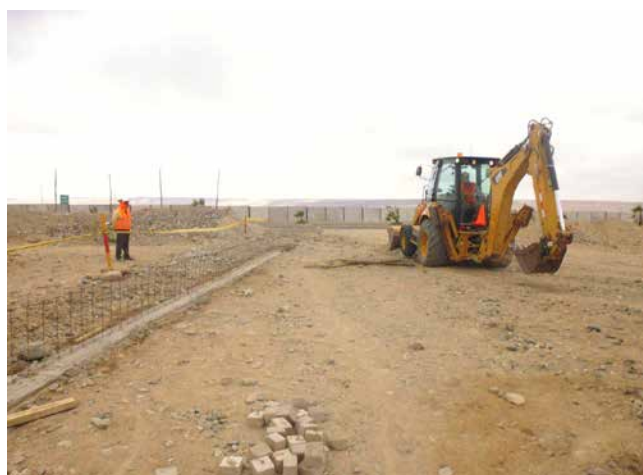
Tacna: Excavación de zanja
