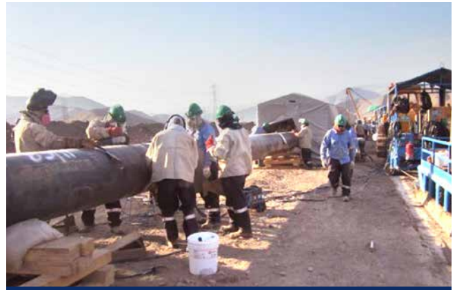
KP. 12 del Loop Costa 2, se aprecia en la vista el desarrollo de actividades de soldadura
