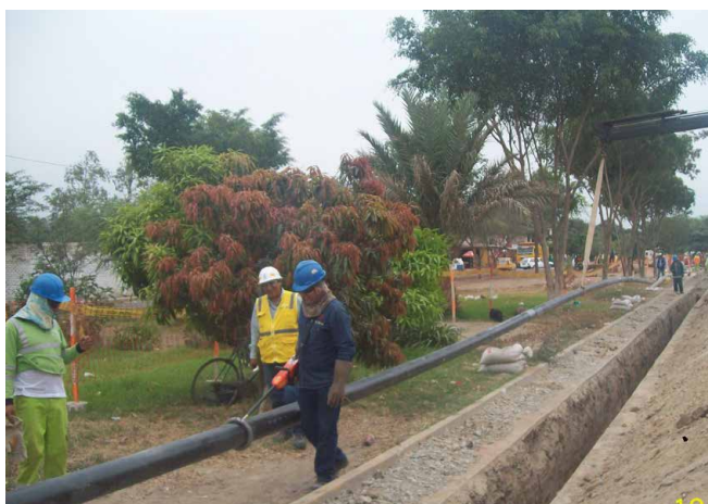
Verificación del estado del revestimiento de la tubería Ø 6", antes de bajarla a la zanja - Gasoducto Urbano Ica.
