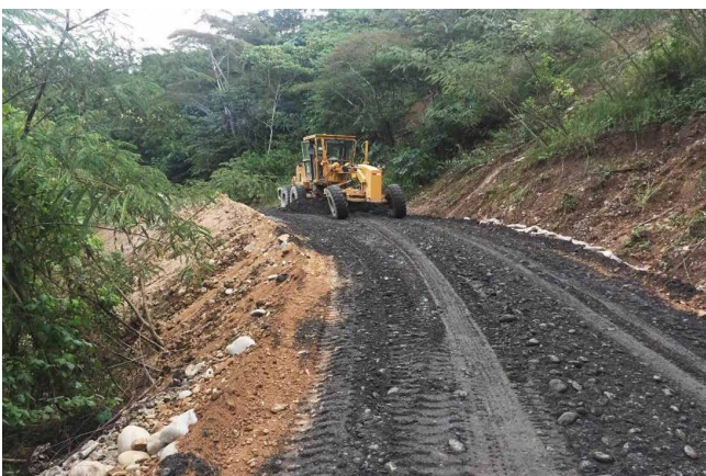
Acceso P1 (Kp 88) - avance: 100%.
