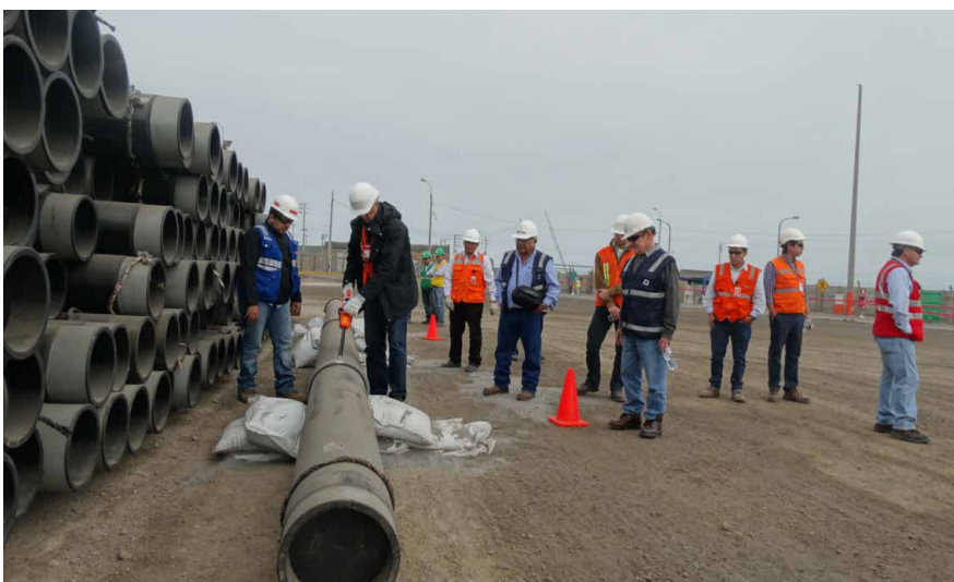
Pasando la herramienta holiday para verificar el estado del revestimiento de un tubo de 14", conforme.
