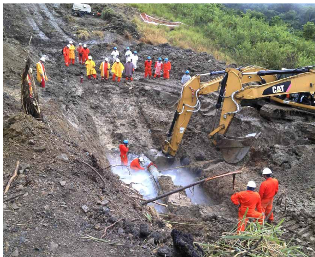
Corte en frío de la tubería, en la zanja se aprecia una nube blanca, la cual es el polvo químico PQS utilizado para prevenir cualquier inflamación de vapores remanentes.
