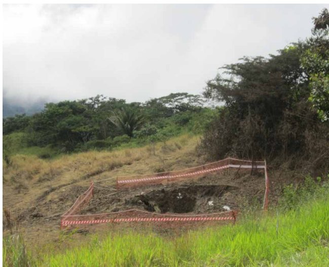
Vista tomada con acercamiento del forado dentro del cual aflora LGN, Aprox. 5 metros de diámetro.
