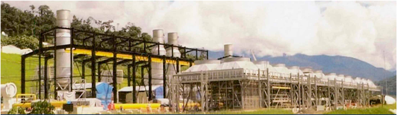
Vista panorámica de la construcción de la planta compresora Kepashiato.
