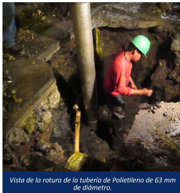
Av. Basadre cruce con la Calle Las Flores en San Isidro
