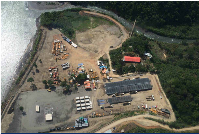
Acopio del Kp 136 - avance: 100%.
