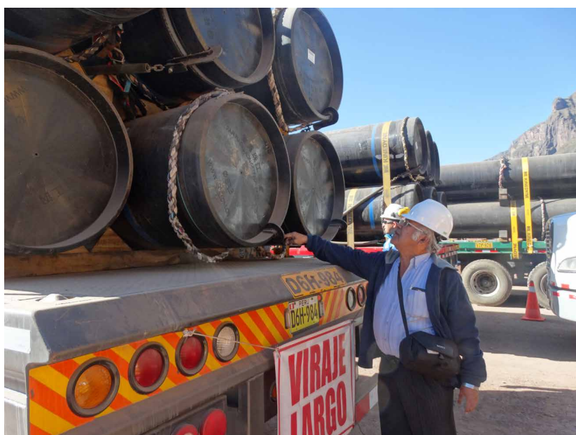
Centro de acopio de tubería Calca, nótese los ganchos y cadenas de retención de la tubería señalados por el supervisor de Osinergmin.
