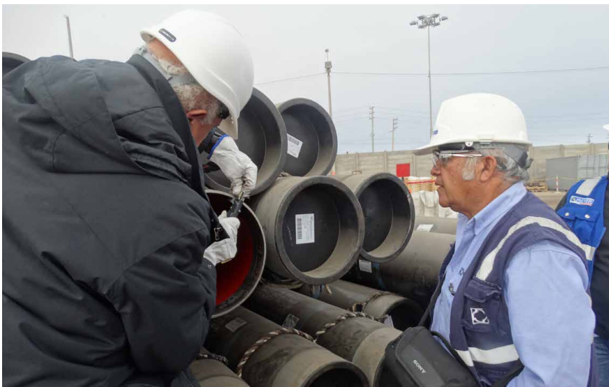
Verificando espesor de un tubo de 14" el cual fue de 8.86 mm que está por encima del espesor nominal, conforme.
