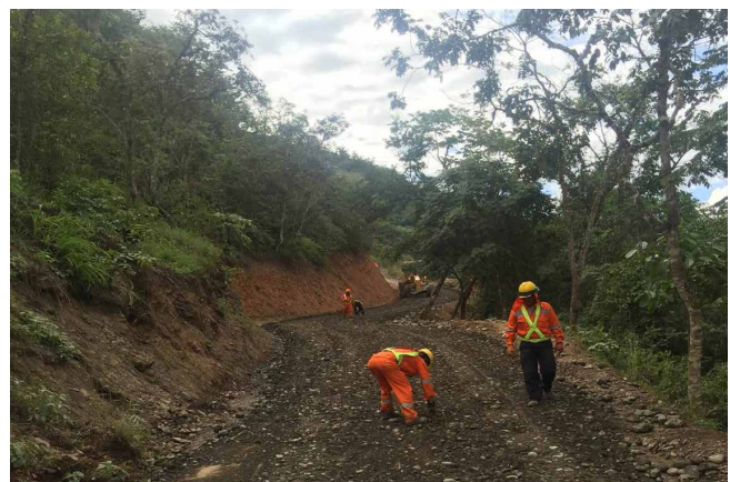
Acceso 07 (Kp 136) - avance: 100%.
