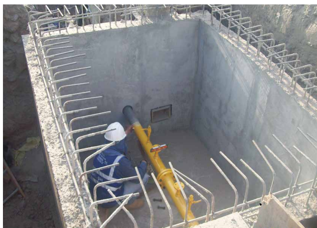
Trabajos de nivelación mecánica en la caja de válvula de GNV, correspondiente al Gasoducto Urbano de Ica.
