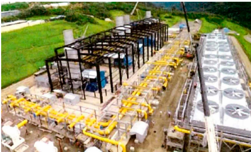
Vista de la instalación de los aerofriadores.
