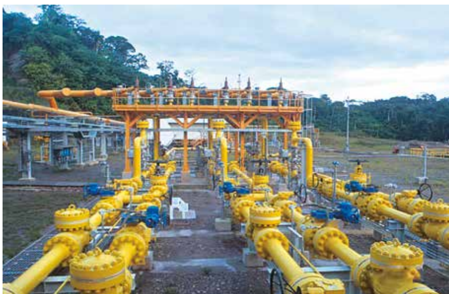
Líneas de Producción de los Tres Pozos de Kinteroni – Lote 57 y la ubicación de los medidores multifásicos
