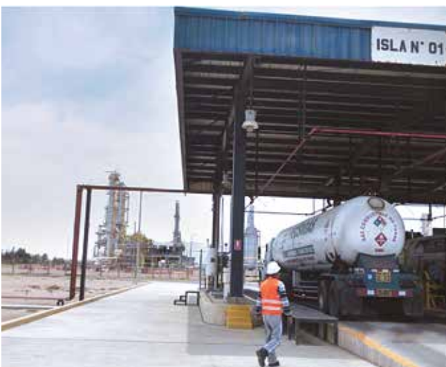
Vista panorámica donde se construirá la quinta isla, al costado del existente, en la losa se colocará la nueva balanza.
