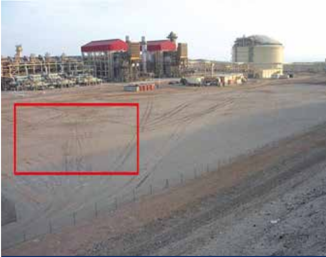
Vista panorámica del lugar donde se construirán los edificios de control del operador, la sala de espera para los conductores de las cisternas y la isla de despacho de GNL.
