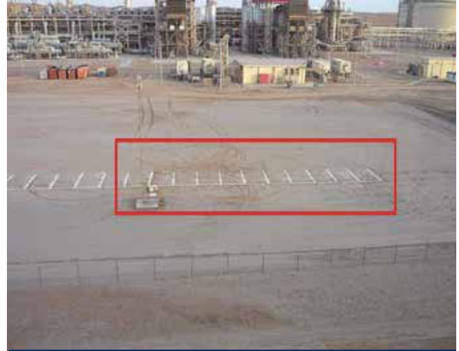
El área donde se construirá la isla de despacho de GNL a camiones cisternas.
