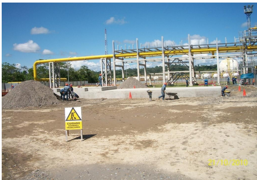
Cimentación de bases donde se instalarán los equipos de procesos
