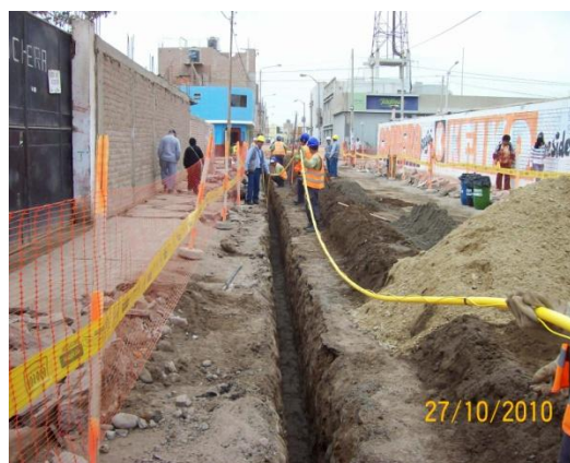
Tendido de tubería en la calle Puno, Proyecto Anillo Vial Central
