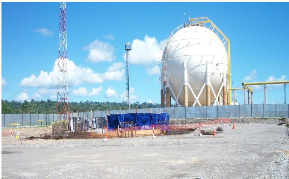
Trabajos en bases de concreto para los nuevos Turbo Compresores
