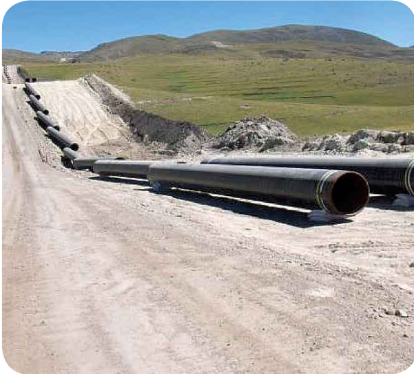
Tubería desfilada en el Kp 128
