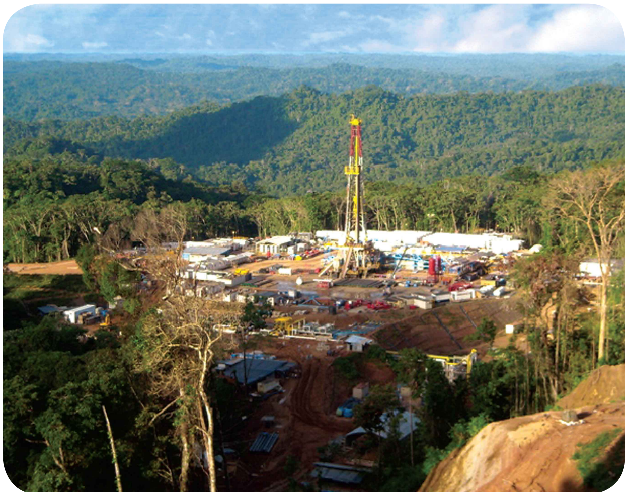
Plataforma de Perforación de los Pozos en Cashiriari 1
