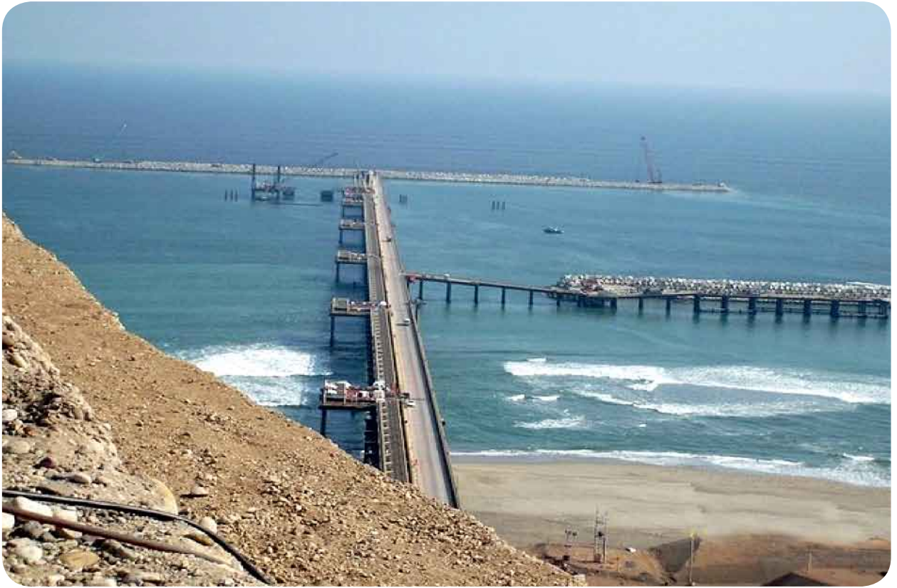
Vista general del Puente de Caballetes y el Rompeolas
