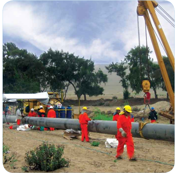
Frente de soldadura previo al cruce de la carretera Panamericana Sur - Cañete
