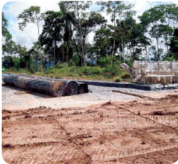
Vista de la geomembrana usada en la protección de la plataforma de perforación
