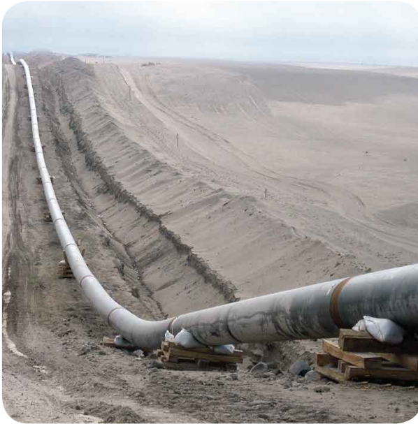
Tubería soldada a la altura del Kp 597
