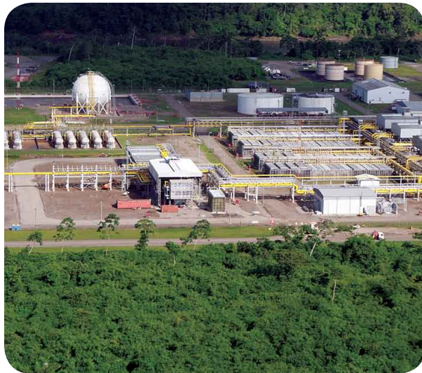
Zona de Turbocompresores de la Planta de Separación de Gas de Malvinas
