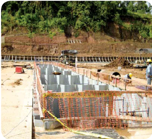
Preparación de la plataforma para la perforación de los 6 pozos
