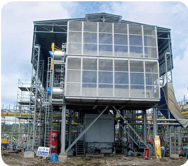
Trabajos para la instalación del quinto Turbocompresor Nuevo Pignone
