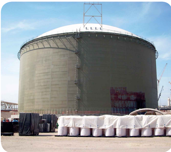
Tanque de almacenamiento de GNL (T-3401)
