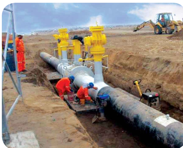
Sellado, compactado y apisonado del terreno
