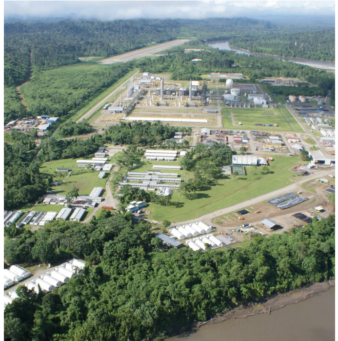
Foto 1. Planta de Procesamiento de Gas Natural, Malvinas.
