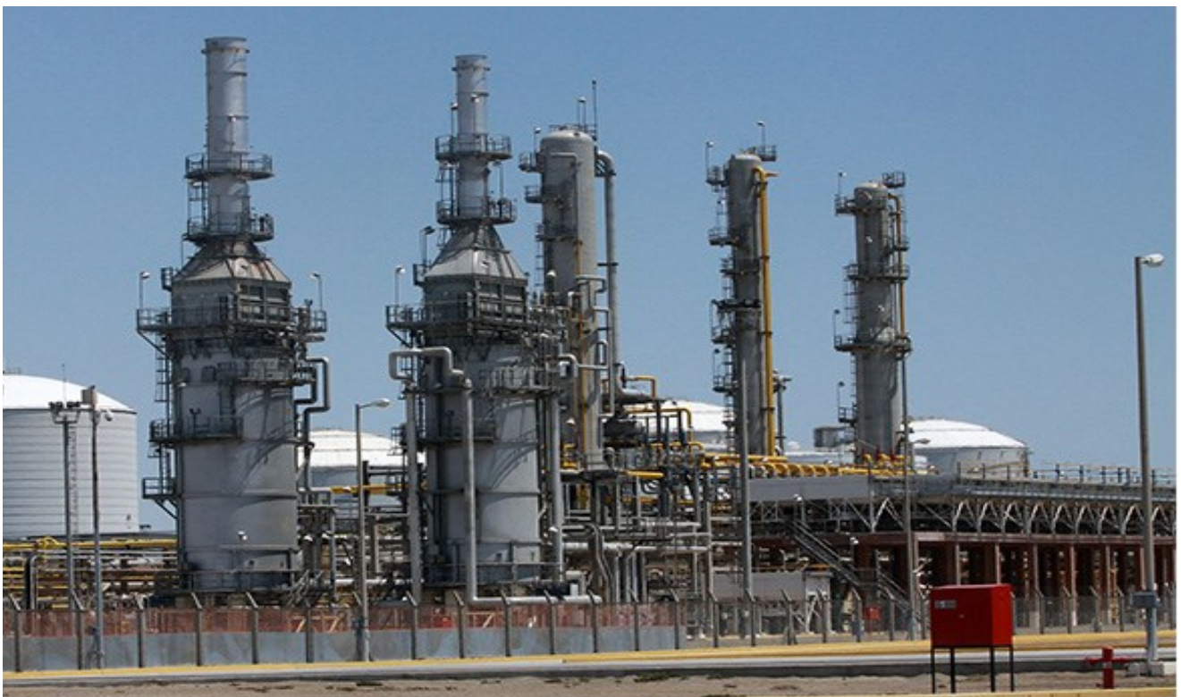
Foto 2. Planta de Fraccionamiento de Líquidos de Gas Natural, Pisco.
