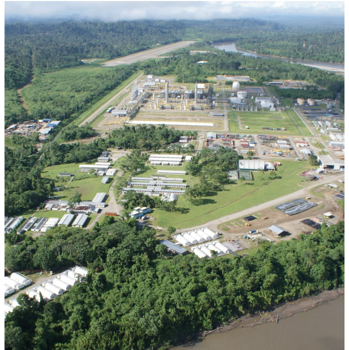
Foto 1. Planta de Procesamiento de Gas Natural, Malvinas.
