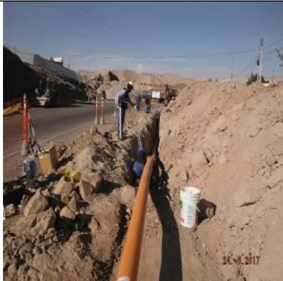
Foto 16- Instalación de Redes en Moquegua: Verificación de la instalación de tubería PE Ø160mm en el CP de San Antonio-Moquegua.
