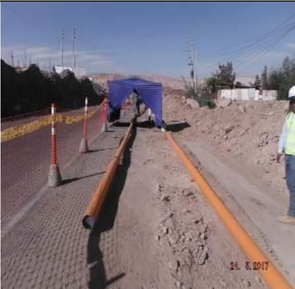
Foto 17.- Instalación de Redes en Moquegua: Verificación de termofusión de tubería de PE Ø160mm en el CP de San Antonio-Moquegua.
