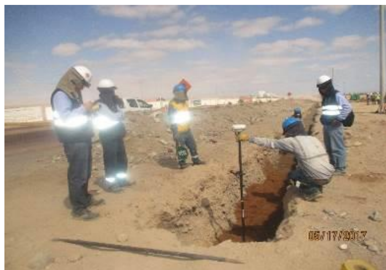
Foto 13.- Instalación de Redes en Tacna: verificación de la instalación de tubería de PE de Ø200 mm.
