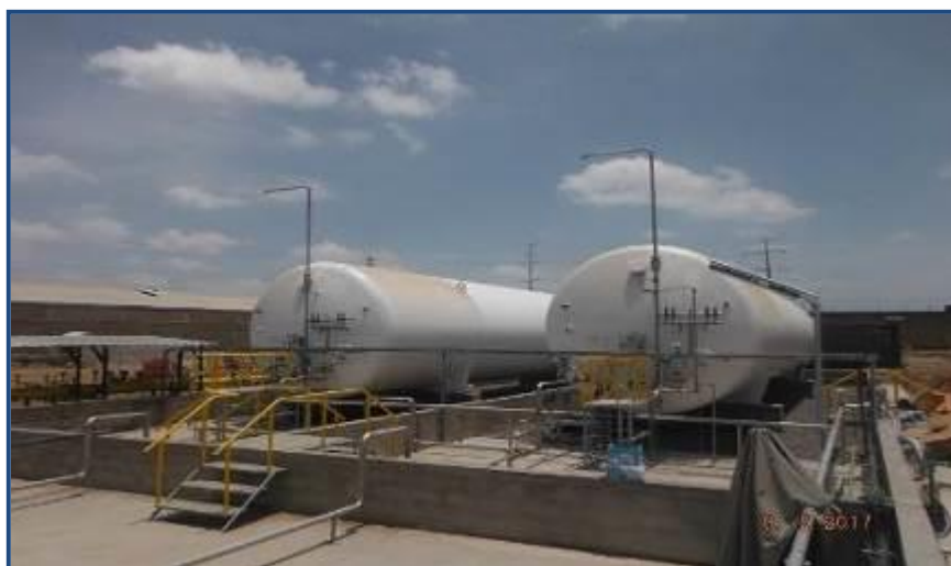
Foto 07: vista del estado actual de estación de distrito de Sabandia
