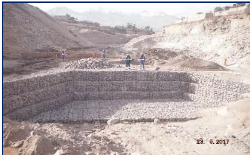
Foto 10.- Redes Arequipa: Se verifica la terminación del gavión principal del cruce especial Torrentera Añashuayco.
