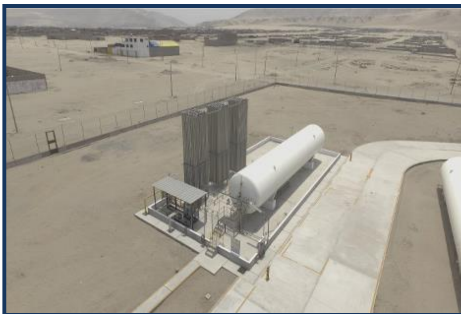
Foto 09.- Vista del estado actual de la estación de Distrito de ILO.
