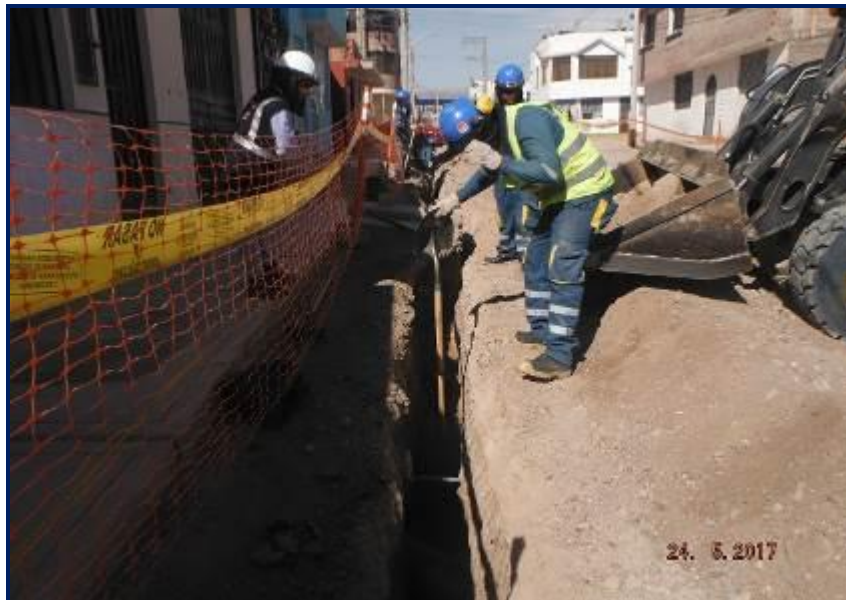
Foto 11.- Redes Arequipa: verificación de instalación de tubería de PE de Ø25 mm en zanja en Distrito de JLByR.
