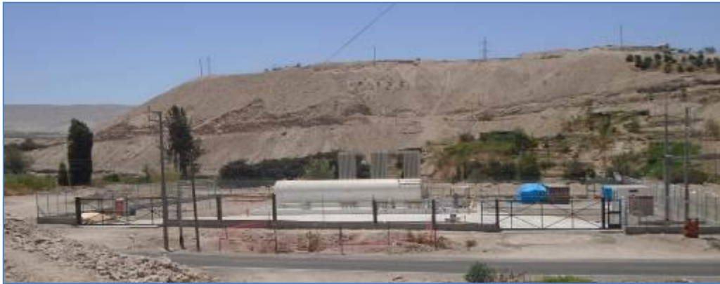
Foto 8.- Vista del estado actual de la estación de Distrito de Moquegua.
