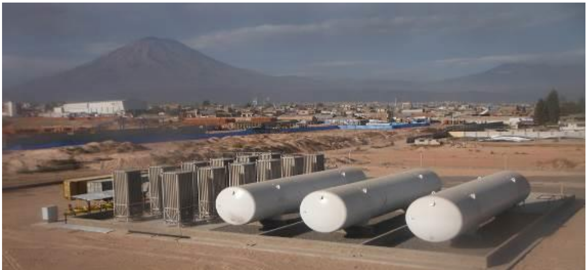
Foto 6: vista del estado actual de estación de distrito de Cerro Colorado
