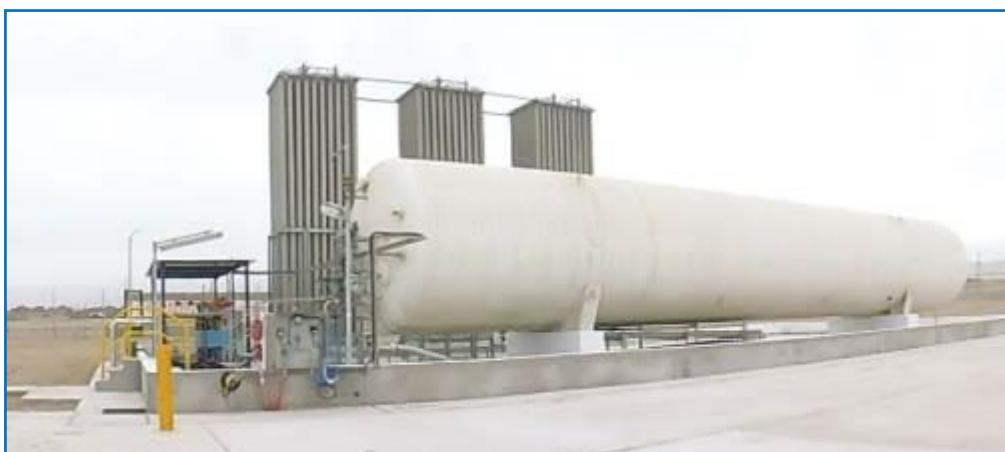
Foto 9.- Vista del estado actual de la estación de Distrito de ILO.
