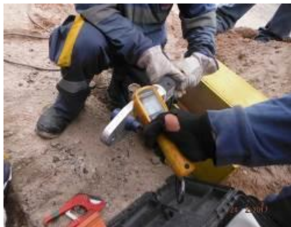
Foto 20.- Instalación de Redes en Arequipa: verificando temperatura de soldadura de tubería de \varnothing 25 mm.
