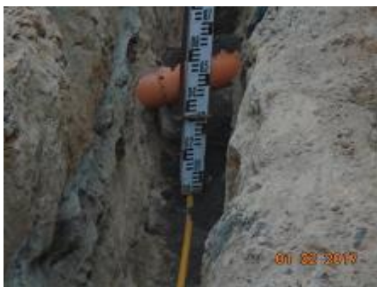
Foto 15.- Instalación de Redes en Arequipa: verificación de profundidad de instalación de tubería y distancia a interferencias
