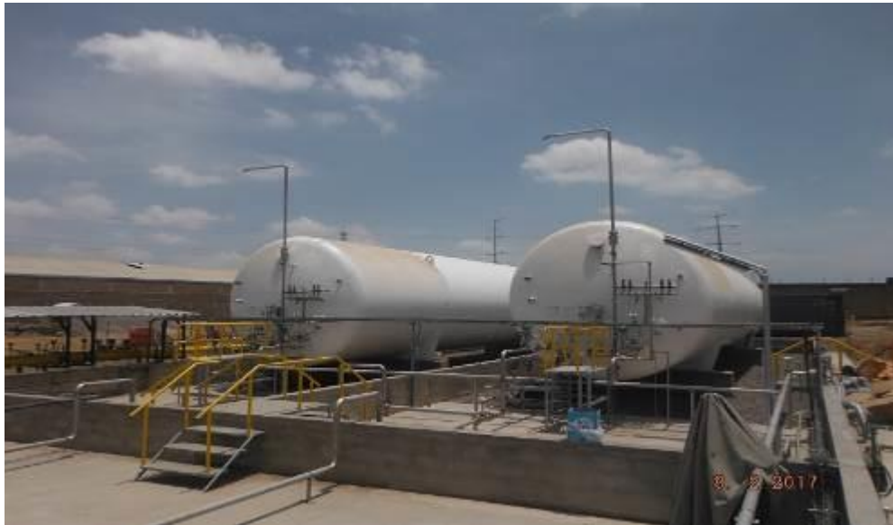
Foto 7: vista del estado actual de estación de distrito de Sabandia
