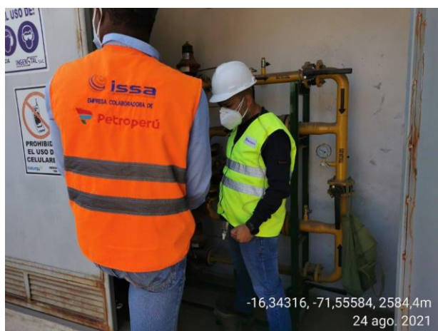
ODORIZACION AREQUIPA: Verificación del nivel de odorante en Ladrillera Oro Rojo, en el distrito de Cayma.
