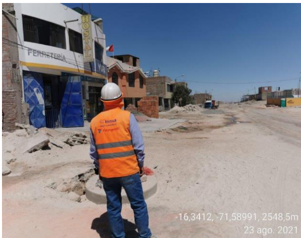
REDES AREQUIPA: Supervisando la presencia de Personal de PPD de PETROPERU, realizando labores de verificación en los trabajos de reposición del terreno en la Av. 03, C.P. PERUARBO, distrito de Cerro Colorado.
