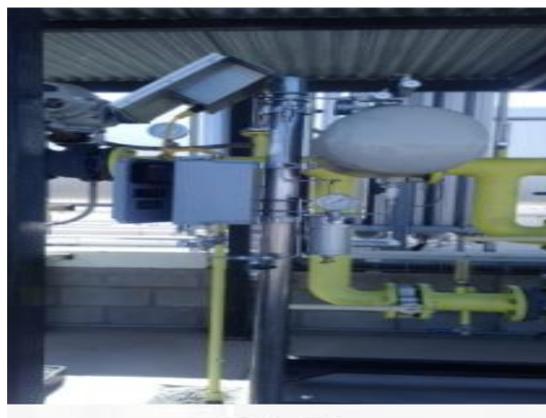
ESTACION DE DISTRITO LA JOYA (AREQUIPA): supervisión a la instalación y montaje del Equipo auxiliar de inyección de odorante.
