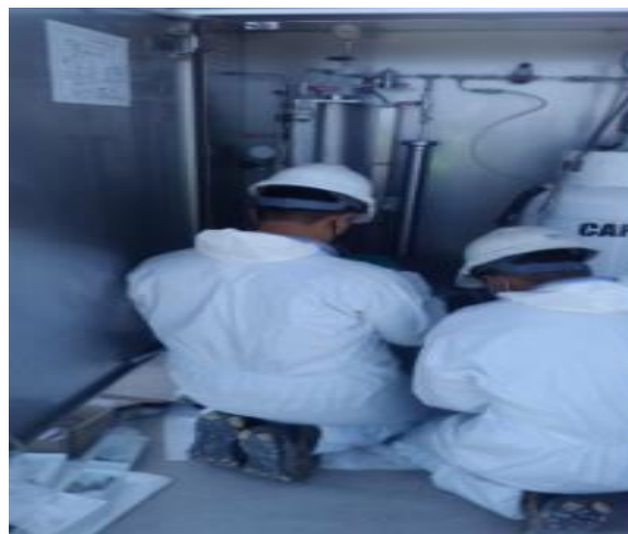
ESTACION DE DISTRITO LA JOYA (AREQUIPA): Supervisión de la instalación y montaje de válvulas y tubería de acero inoxidable al Equipo de inyección de odorante.
