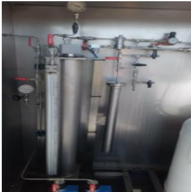
ESTACION DE DISTRITO LA JOYA (AREQUIPA): Supervisión de la instalación y montaje de válvulas y tubería de acero inoxidable al Equipo de inyección de odorante.
