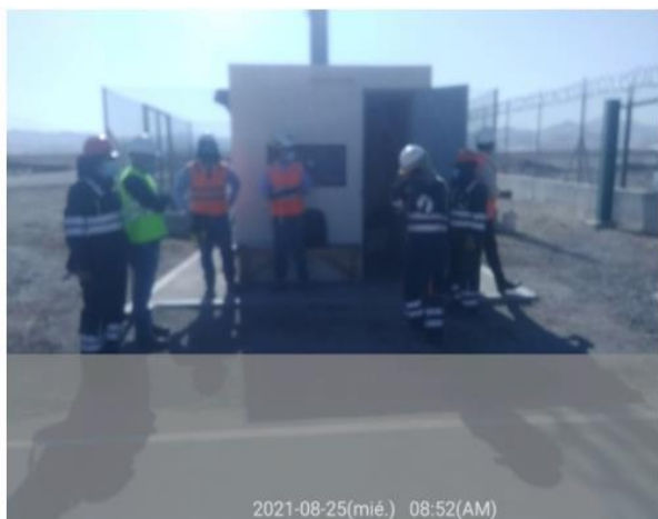
ESTACION DE DISTRITO LA JOYA (AREQUIPA): Vista de control de personal a la estación para dar inicio de los trabajos de modificación del Sistema de Odorización.
