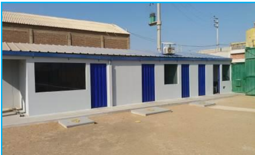
Foto 09.- Vista de las oficinas con sus puertas y ventanas instaladas.
