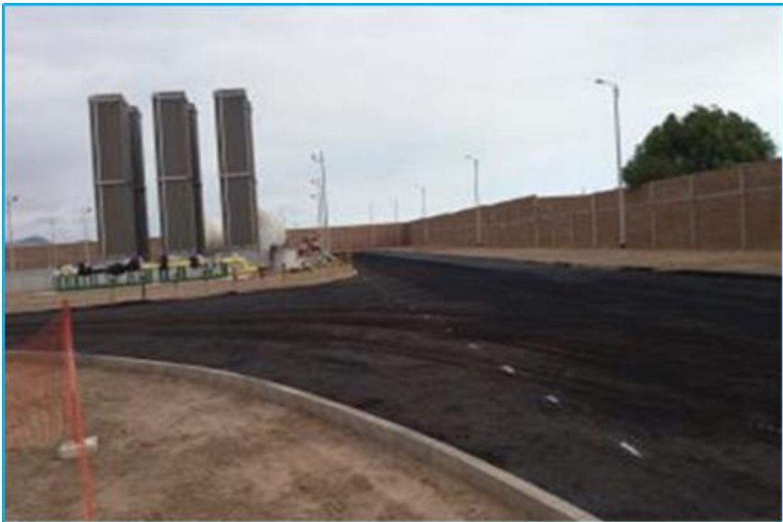
Foto 1.- Vista de la Estación de Distrito Trujillo, con su pista asfaltada
