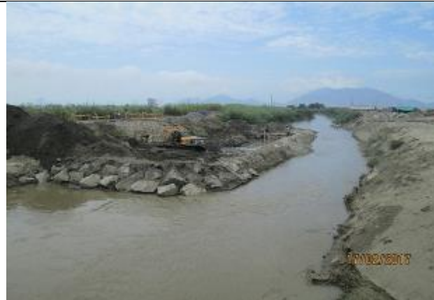
Foto 17.- Vista de trabajos de derivación de agua en Cruce del Río Lacramarca en Chimbote.
