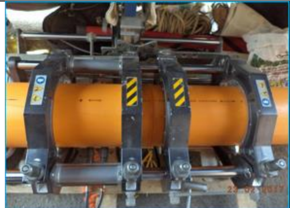
Foto18.- Redes de Trujillo, vista de los trabajos de unión de tubos de PE Ø200mm, proceso Termofusión.
