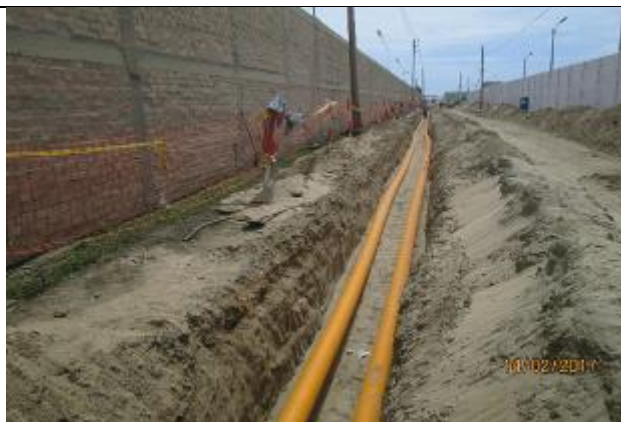
Foto 19.- Redes de Chimbote.- Tendido de tubería de Ø200mm en Jr. Santo Toribio.
