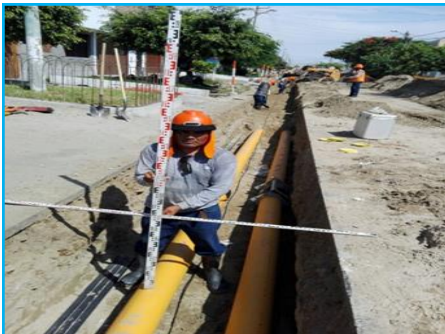
Foto 12.- Verificación de distancias de tuberías hacia interferencias, en Av. Los Pescadores.
