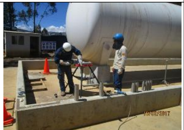
Foto 20.- Vista de la preparación de niples de Acero Inoxidable para soldeo en la E.D. de Huaraz.
