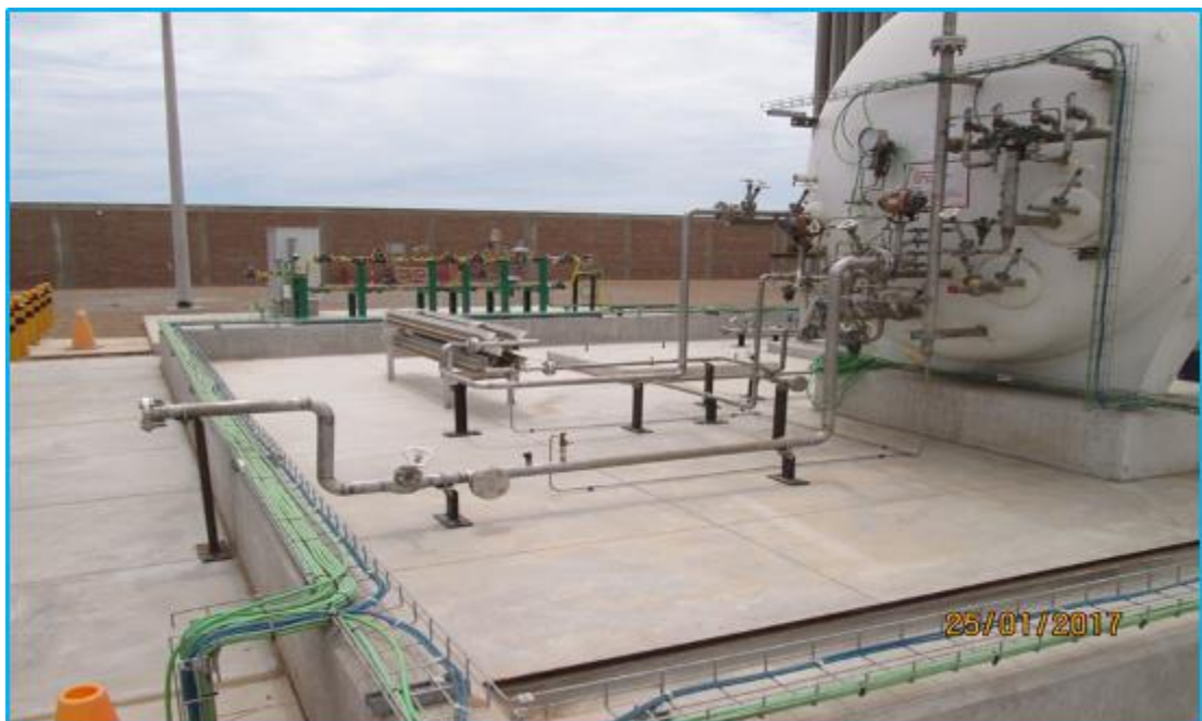
Foto 2.- Vista de la E. D. Pacasmayo, instalación de cables eléctricos y de instrumentación en zona de procesos.
