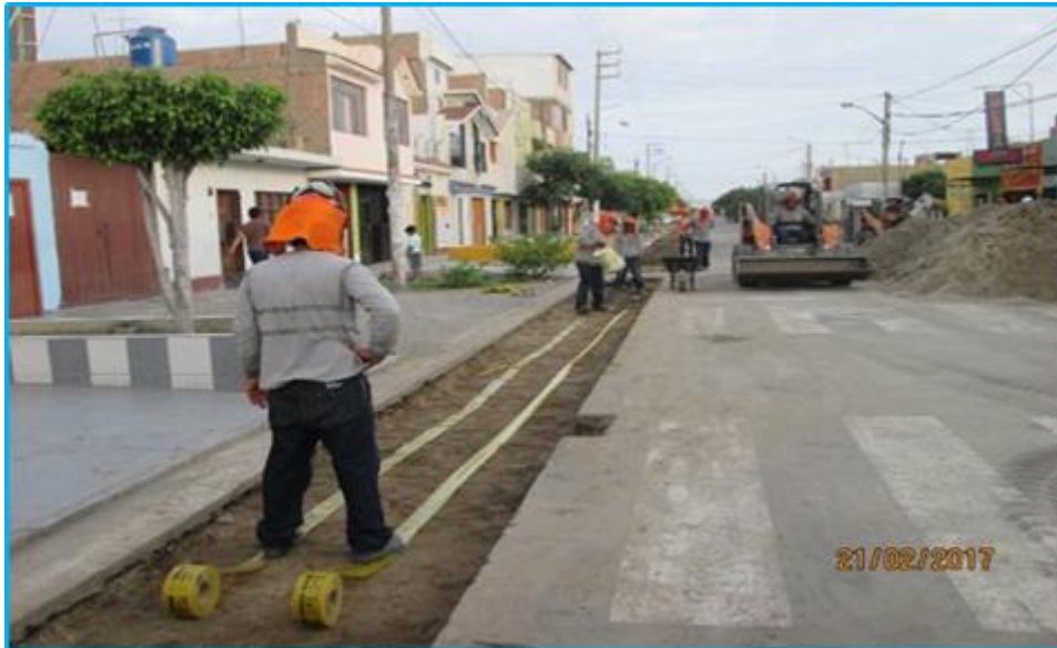
Foto 13.- Vista de la Instalación de cinta de señalización, en proyecto: PE-16-015, en Urb. El Trapecio - Tercera Etapa.
