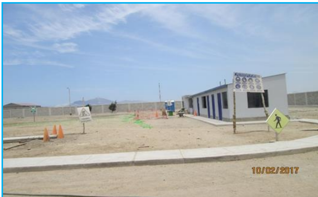
Foto 11.- Vista de oficinas y almacenes, así como la pista de rodadura vehicular, pendiente asfaltado.
