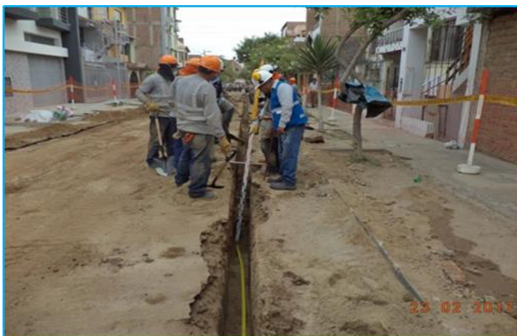
Foto 07.- Redes Trujillo, verificación de profundidad de zanjas en Calle Luis Montero.
