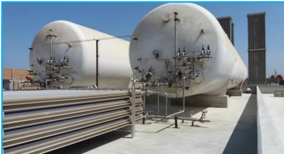
Foto 05.- Vista de zona de procesos, trabajos de montajes de tuberías terminado.
