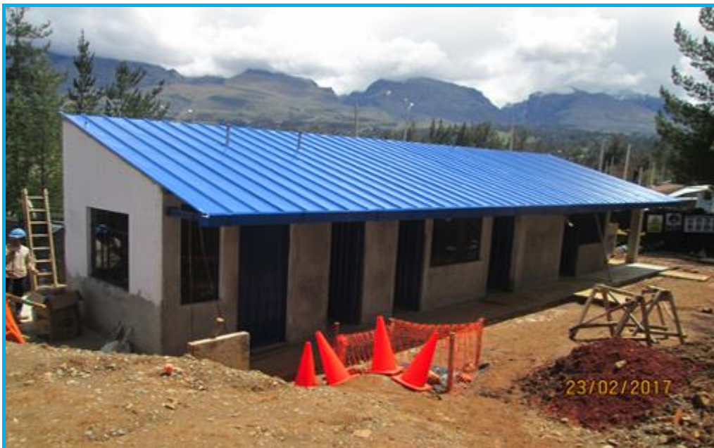
Foto 14.- Vista de oficinas, en trabajos de acabados.
