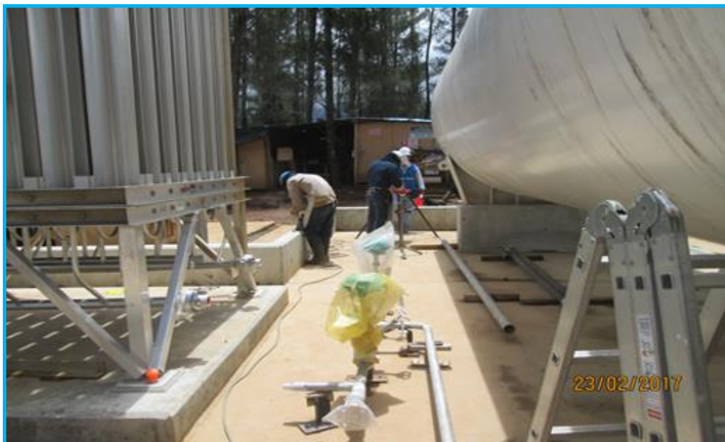
Foto 15.- Vista de trabajos de corte y biselado de tubos de acero inoxidable.
