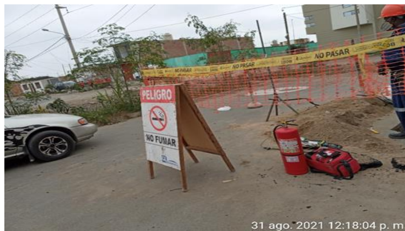
Foto N° 12.- Gasificado de redes. Se aprecia la prueba de la línea con gas (5.0 bar). Se verifica la no existencia de fugas. Ref. Av. Los Álamos en UPIS San Diego - Nuevo Chimbote (PE-20-103).
