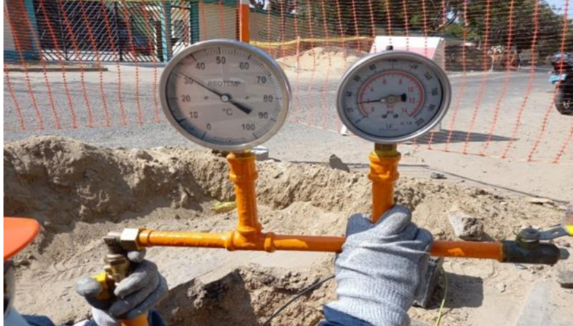
Foto N° 13.- Prueba de Presión en red común gasificada.
