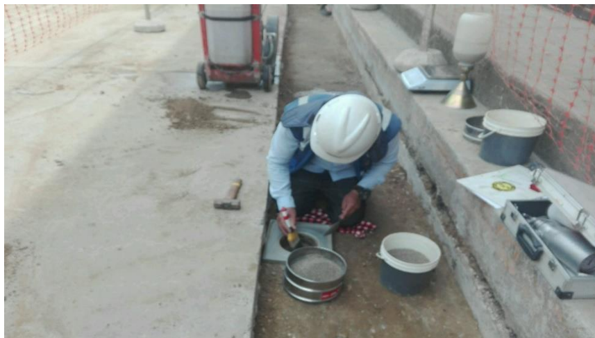
Foto N° 9- Se supervisa el ensayo de compactación de terreno – Proctor.
