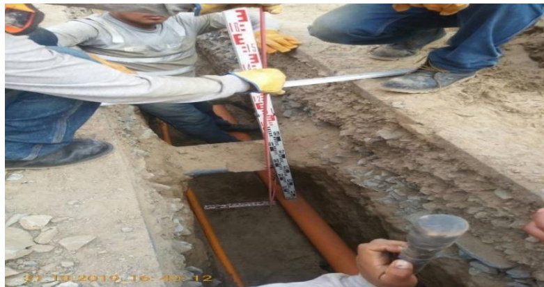
Foto N° 3.- Supervisión de la validación de distancias entre tuberías de gas y distanciamiento a interferencias (mínimo 0.30 m).
