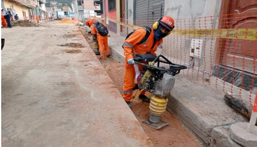
Foto N° 7.- Se supervisa la compactación del terreno. Ref. Proyecto Cajamarca.
