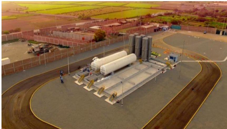
Foto N°15.- Vista panorámica de la Estación de distrito de Trujillo.
