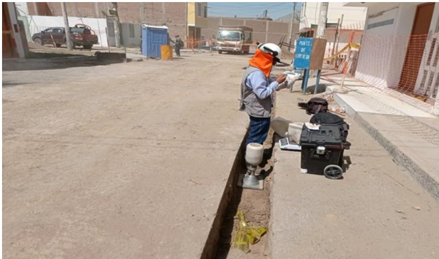
Foto N° 8- Se supervisa el ensayo de compactación de terreno – Proctor.
