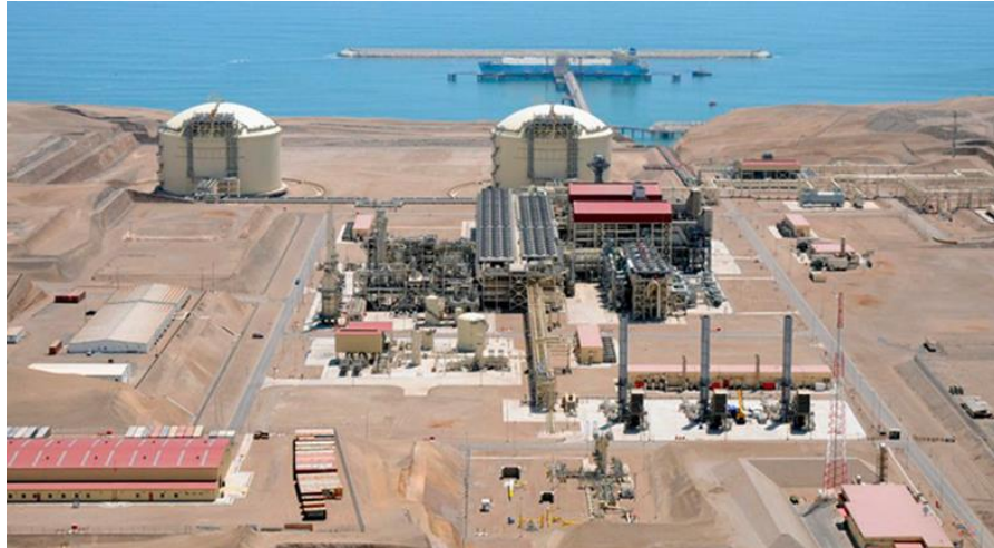
Foto N° 14.- Vista Panorámica de la Planta de GNL de Pampa Melchorita de Cañete. Abastecedor de GNL a la concesión norte.
