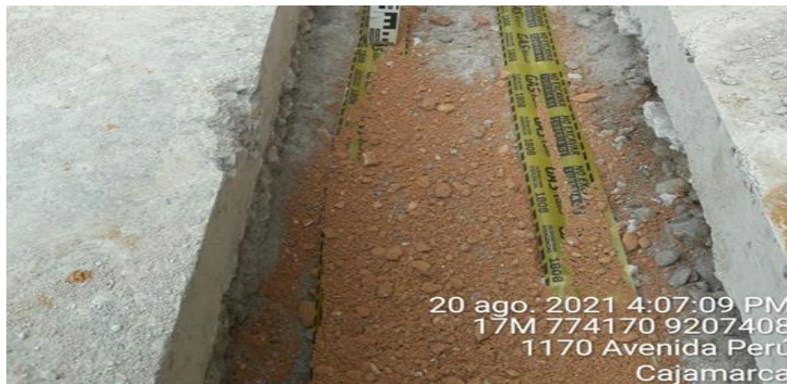
Foto N° 6.- Se supervisa la instalación de la cinta de seguridad de señalización antes de cerrar la zanja donde se ha instalado la tubería de Pe de distribución de gas natural.
