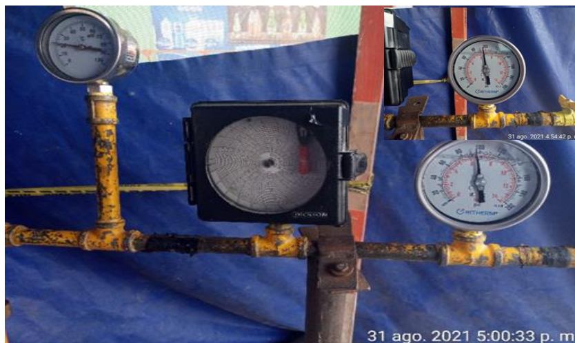
Foto N° 11.- Supervisión de prueba de presión; cabezal primario. Ref. Urb. Luis Felipe de las Casas - Nuevo Chimbote (PE-20-104).
