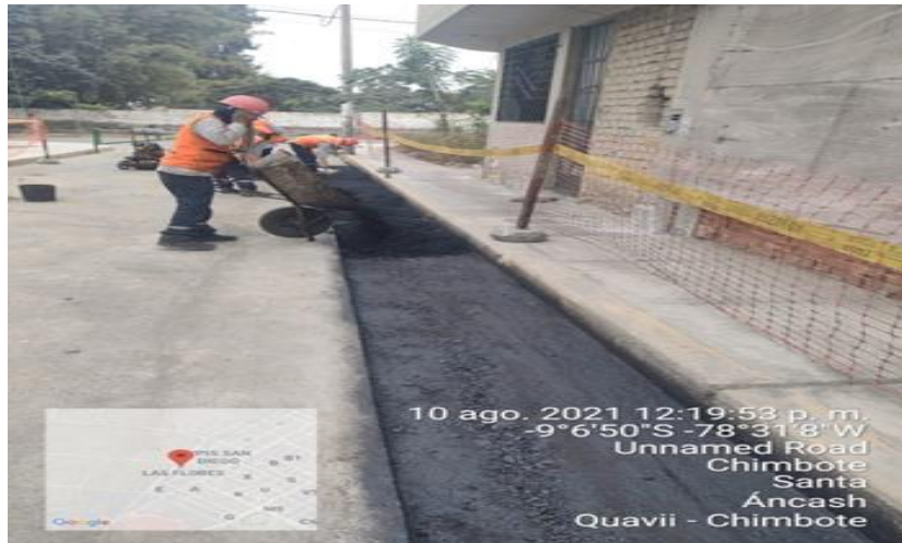
Foto N° 10.- Se supervisa la reposición de pavimento - asfaltado de calle en Chimbote.
