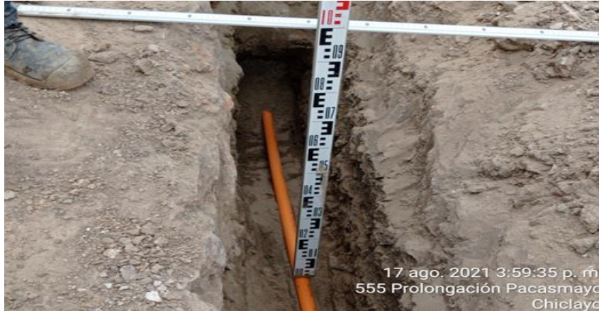
Foto N° 4.- Verificación de la profundidad de tapada de tubería, mínimo 0.61 m. Ref. Proyecto Chiclayo.
