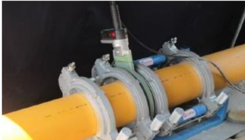
Foto N° 2.- Unión de Tuberías de PE: en este caso se trata de una unión por termofusión de tuberías PE Ø160 mm, proceso de unión a tope.
