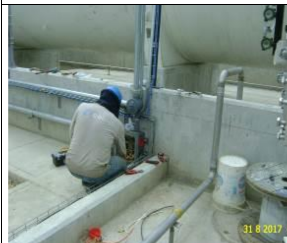
Foto 16.- E.D. Cajamarca, instalación de cableado eléctrico en electrobomba de GNL.
