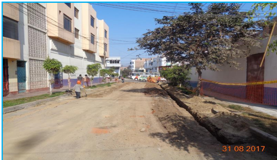
Foto 08.- Redes Trujillo, vista de la excavación e instalación de tubería de PE de Ø32mm en la Calle Iquitos, Urb. Aranjuez.
