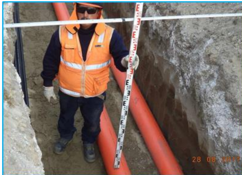
Foto 11.- Redes Chimbote, verificación de la altura de tapada de zanja.
