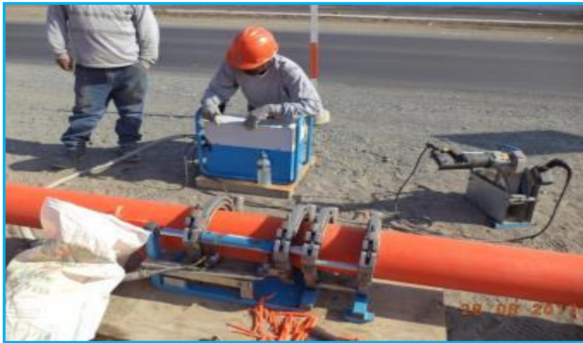
Foto 10.- Redes Chimbote: vista de proceso de unión a tope por Termofusión, se cumple con lo indicado en ASME Secc. IX.: Temperatura dentro del rango, etc.
