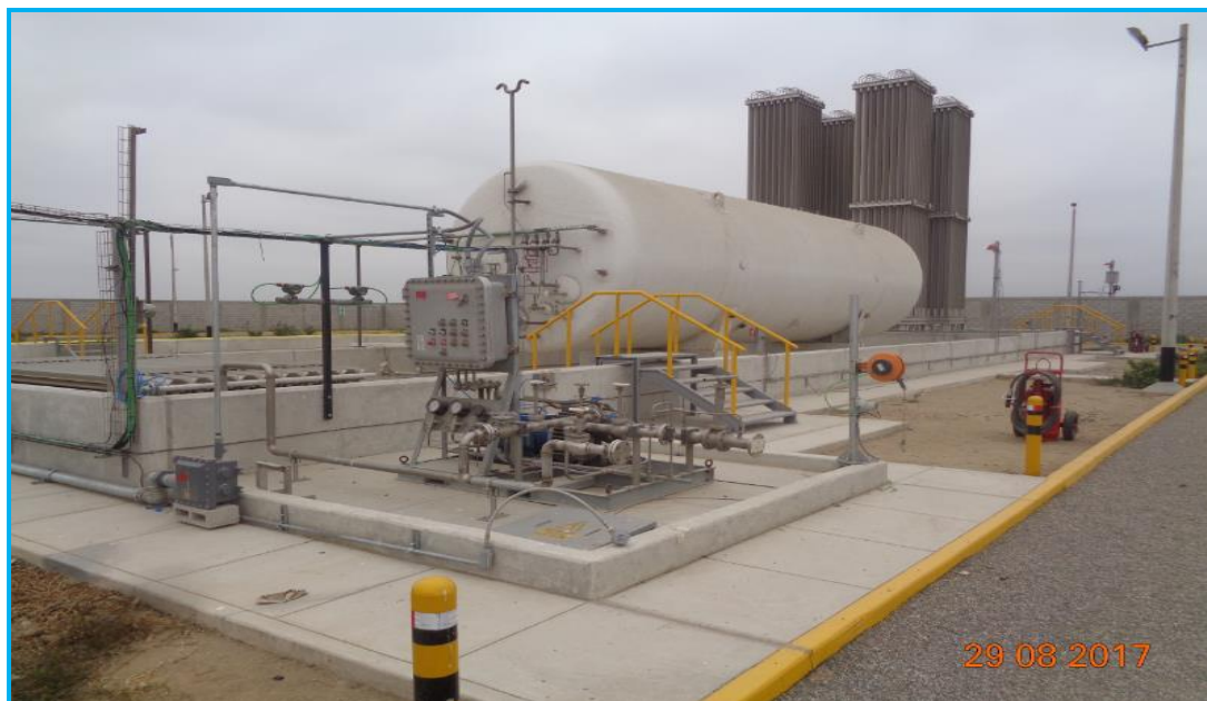
Foto 04.- Vista de la Estación de Distrito de Chiclayo
