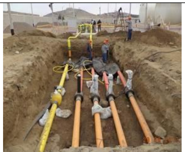
Foto 17.- E.D. Chimbote, vista de las pruebas de hermeticidad de los tramos de tubería de PE en interior de la estación de distrito.
