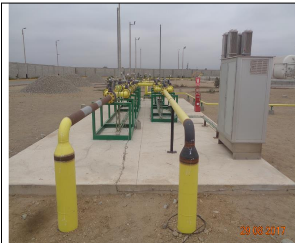
Foto 14.- Estación de Distrito Chiclayo, vista de la unión de las transitomas a la tubería de gas de Polietileno subterránea.
