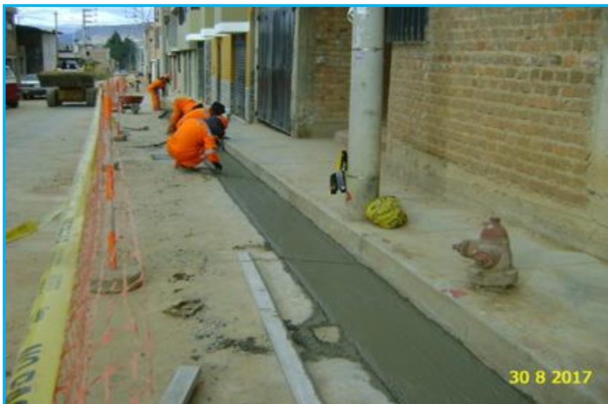
Foto 13.- Redes Cajamarca, vista de la reposición de pavimento (cuneta de concreto).
