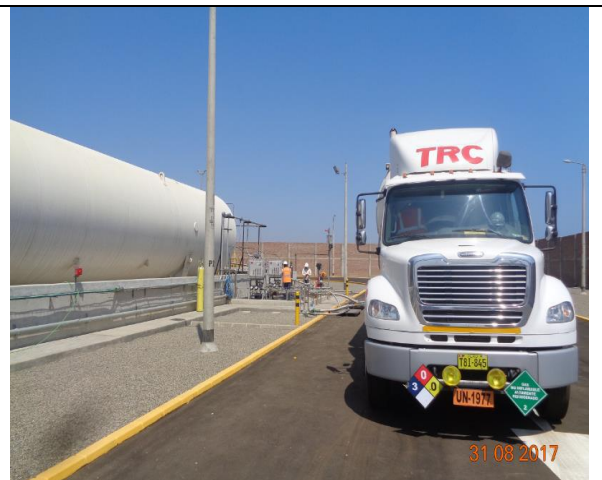
Foto 15.- Estación de Distrito Trujillo, vista de la verificación de trabajos en zona de descarga de GNL para su preparación para las pruebas de la puesta en operación comercial.
