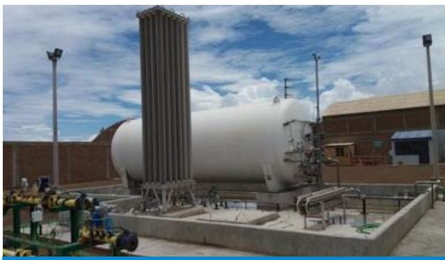
Vista de la Estación de Distrito de Pacasmayo.
