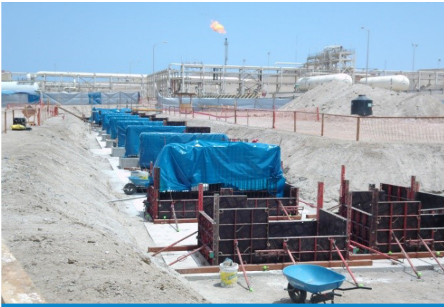
Construcción de pedestales de soportería para las tuberías.
