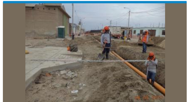
Redes de Chimbote: Instalación de tubería de PE Ø200 mm entre las cuadras 3 y 4 de la Av. Brasil.
