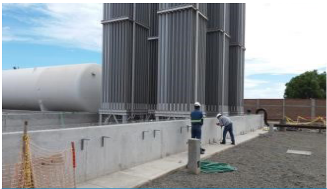
Vista de la Estación de Distrito de Trujillo.
