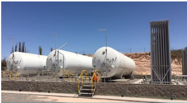
Vista de la Estación de Arequipa Norte.
