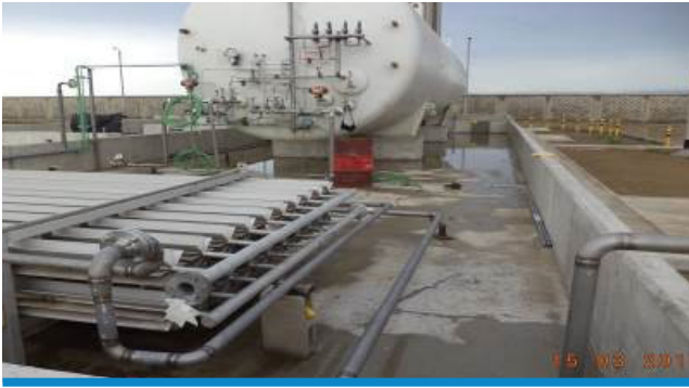
Vista de la Estación de Distrito de Chiclayo.
