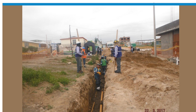
Redes Arequipa: Instalación de tubería PE de Ø25 y Ø90 mm.
