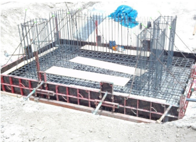
Armadura de la cimentación para puente N°2 de la soportería de tubería.
