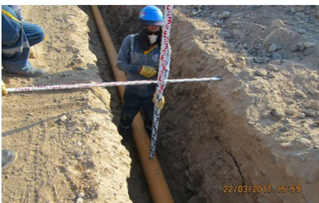
Redes Tacna: Verificación de la profundidad de tubería de Ø200mm.
