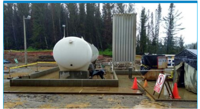
Vista de Estación de Distrito de Huaraz.
