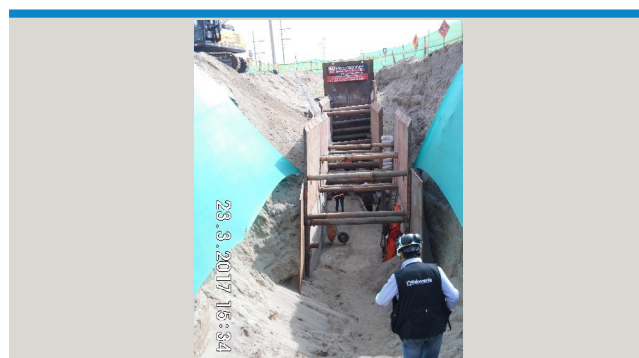
Cruce especial con gasoducto de TGP, proyecto Extensión de red Cluster Chilca, distrito de Chilca, provincia de Cañete.
