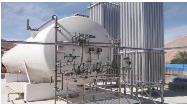
Vista de la Estación de Moquegua.
