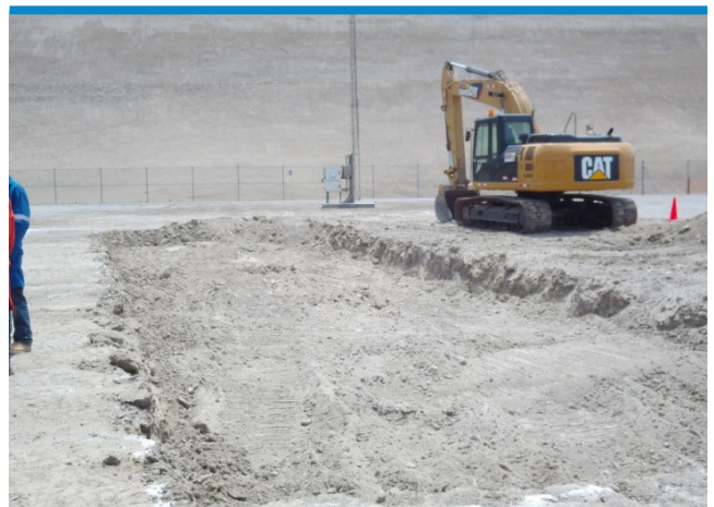
Excavación en zona de carguío de GNL a camiones.
