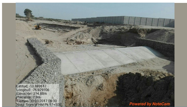
Trabajo final, cruce especial con lastre que contiene tubería de acero de 20", Cruce Río Seco.
