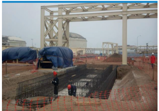
Vista de la construcción de la cimentación de balanza de carga.
