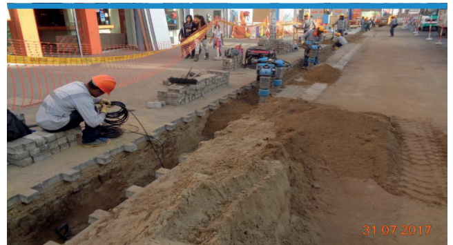
Redes de Trujillo: Instalación del cable conductor eléctrico y trabajos de compactación del terreno. Ref.: Av. América Sur, Cdra. 13. 31 07 2017
