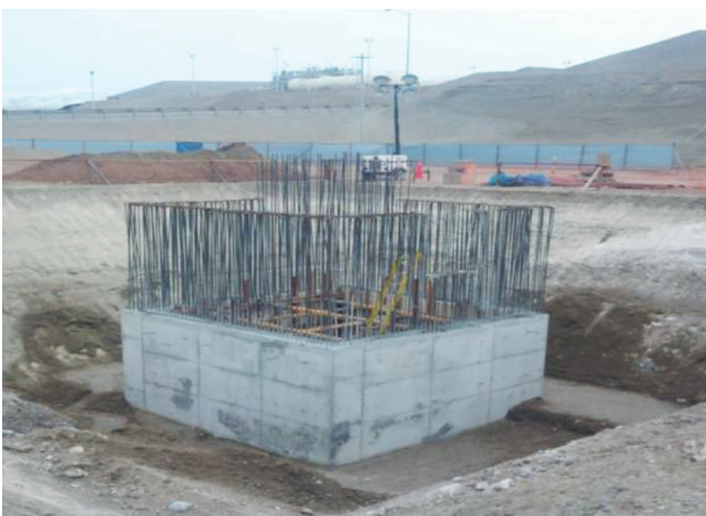
Vista de la construcción de poza de derrame.
