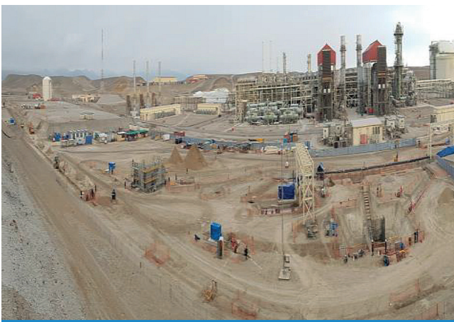
Vista panorámica de construcción del Cargadero de GNL
