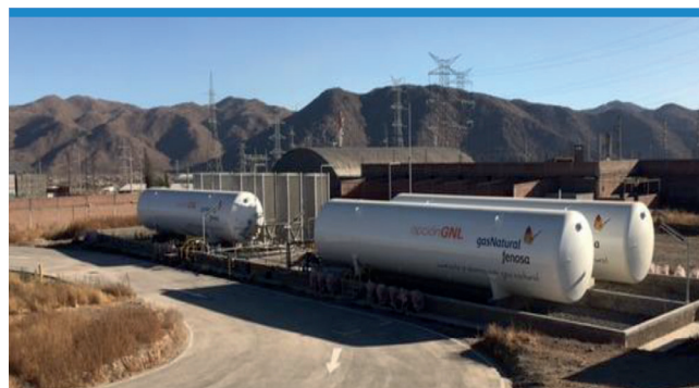
Vista de la Estación de Arequipa Sur.
