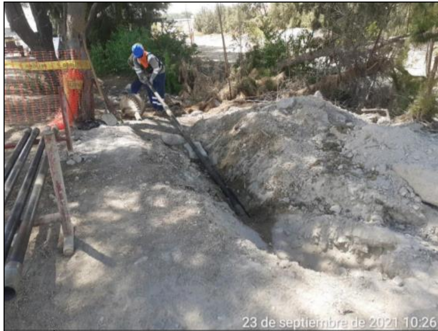
Foto: Punto de salida de la perforación horizontal dirigida para el cruce especial de la Quebrada Las Monjas.
