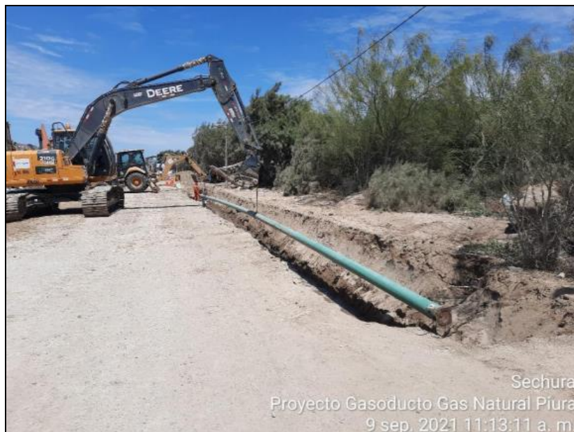
Foto: Se aprecia el proceso de bajada de tubería en zanja. Trabajo correspondiente al tramo 11 del gasoducto.
