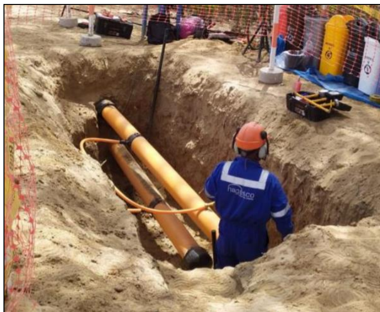
Foto: Se observa los trabajos de unión de tubería de polietileno de 160 mm de diámetro.
