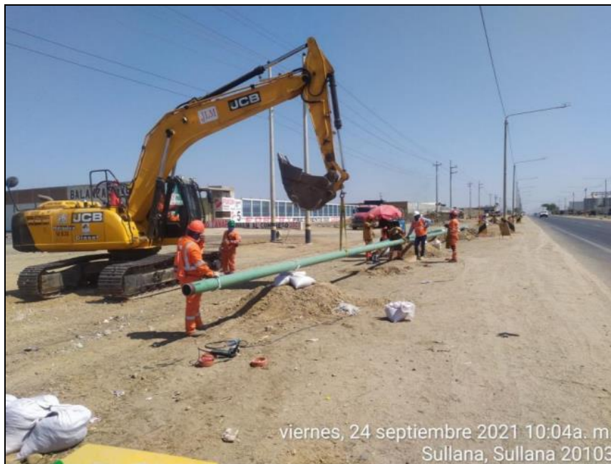
Foto: Se aprecia el alineamiento de tuberías como parte de los trabajos preliminares para la construcción del tramo 6 del gasoducto.
