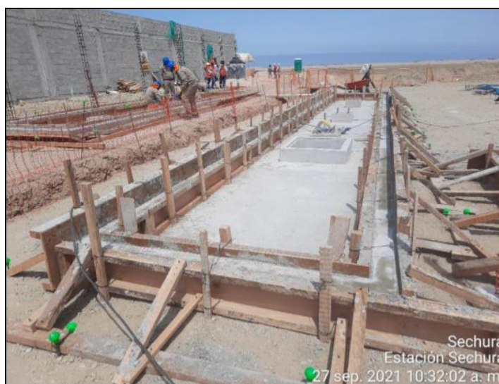
Foto: Se observa los trabajos de construcción de base de skid's y muro perimetral de la estación
