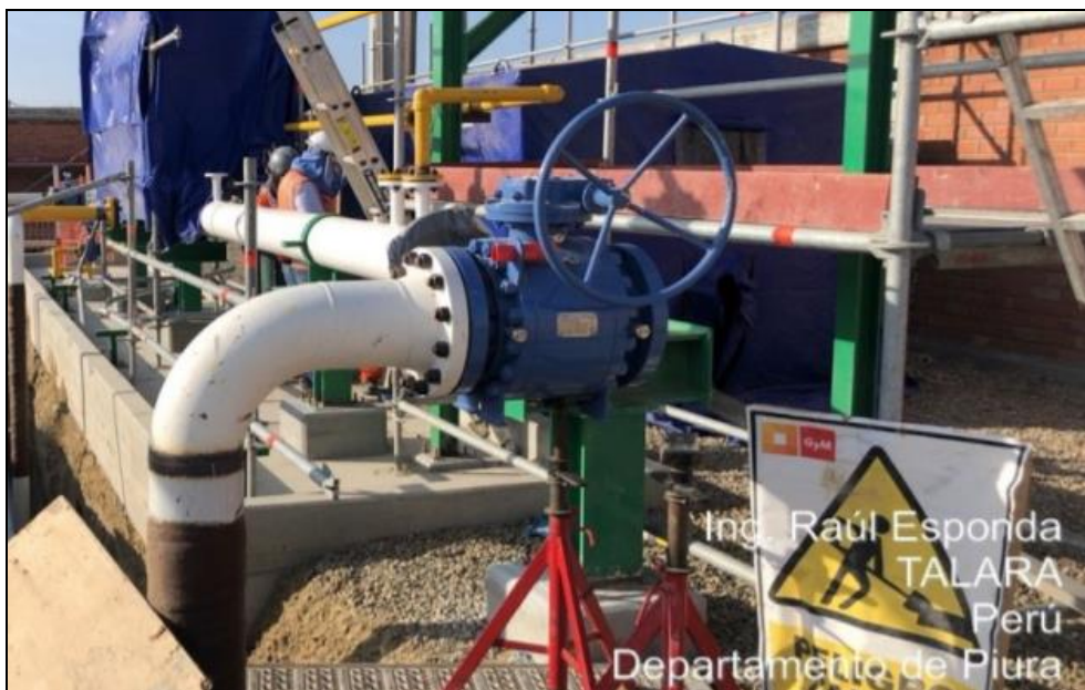
Foto: Se observa los trabajos de mantenimiento en la estación de distrito de Talara - Piura
