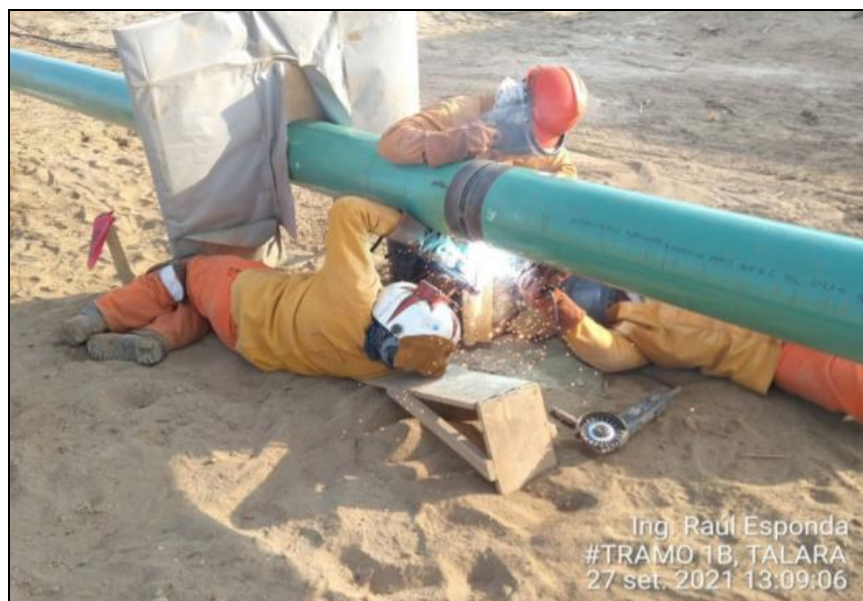
Foto: Proceso de soldadura de tubería de \varnothing 10'' correspondiente al tramo 1AB del gasoducto.
