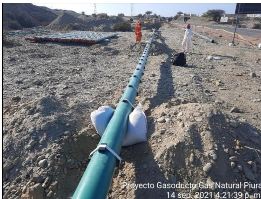
Foto: Trabajos preliminares y preparación de tubería para realizar el cruce especial del tramo 12 con el Oleoducto Nor-Peruano (ONP).
