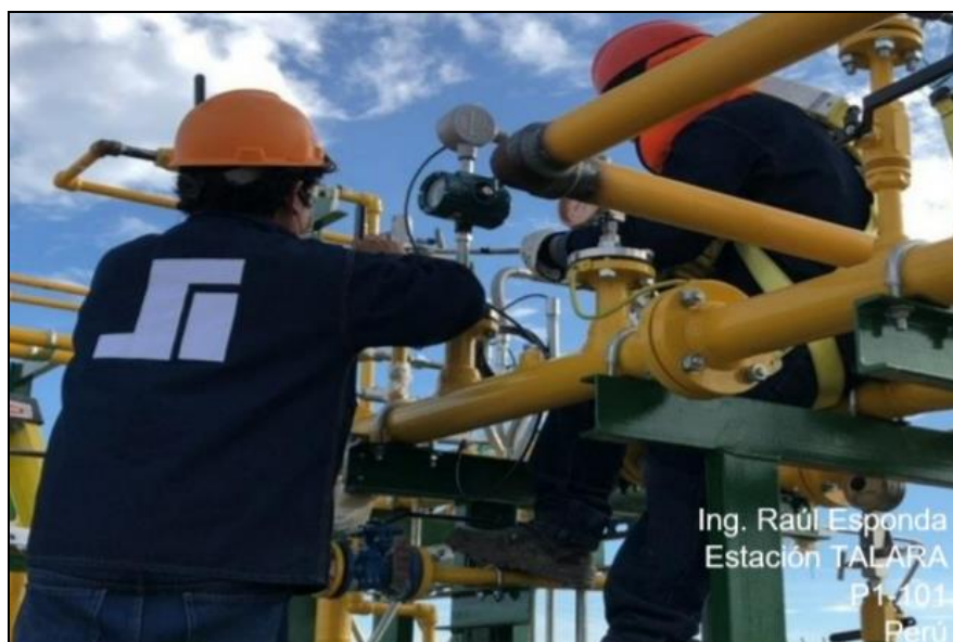
Foto: Se observa los trabajos de mantenimiento de instrumentos en el Skid de regulación y medición de gas.
