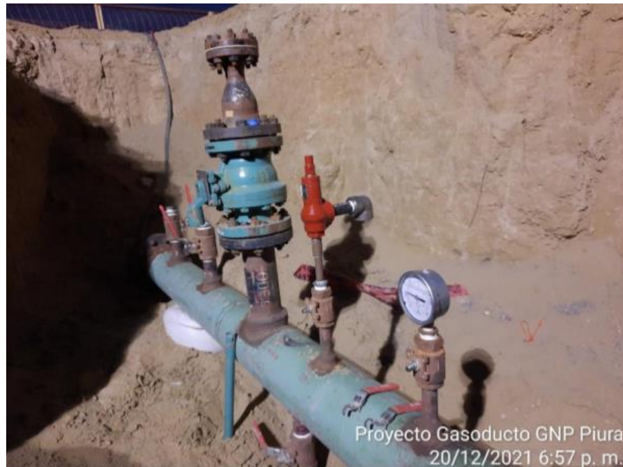
Foto: Se aprecia el manifold de prueba, para realizar la prueba hidrostática del tramo 11 del gasoducto.
