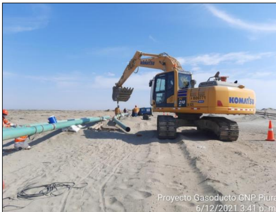
Foto: Se aprecia los trabajos de alineamiento de tuberías Ø10", con la ayuda de un cargador frontal, corresponde a la construcción del tramo 4 del gasoducto.
