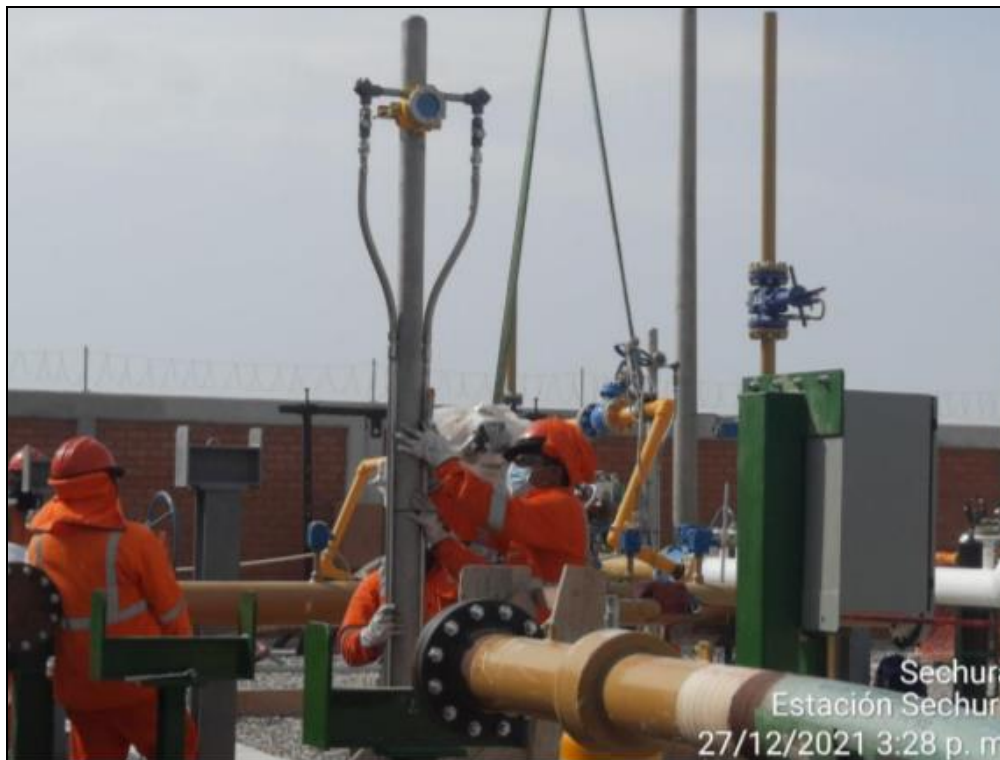
Foto: Se observa los trabajos de Instalación de líneas para Fire&Gas en zona trampas.
