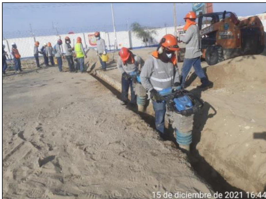
Foto: Se aprecia los trabajos de compactación de terreno, luego de haber instalado la tubería de polietileno en el distrito Veintiséis de Octubre.
