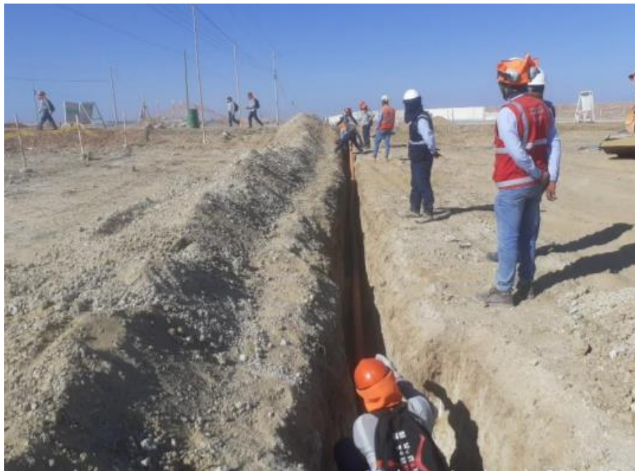
Foto: Se aprecia los trabajos de Instalación de tubería de polietileno de Ø110mm.
