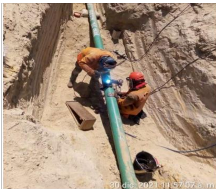
Foto: Se aprecia el proceso de soldadura de tubería de Ø6", corresponde a la construcción del tramo 6 del gasoducto.
