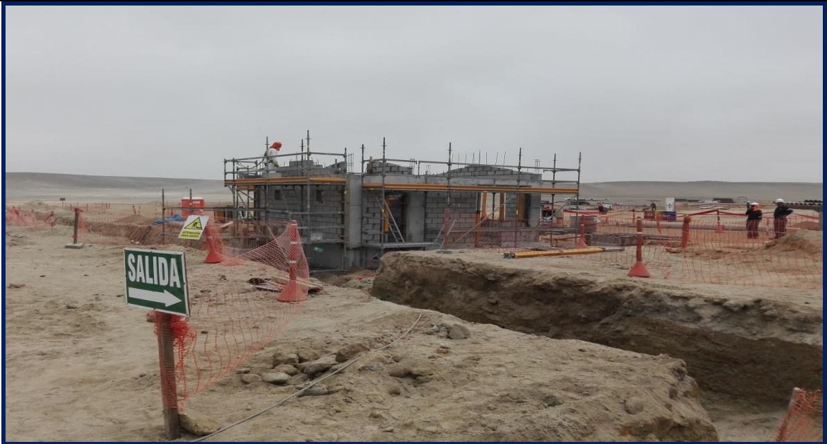
Foto 1. Vista de construcción de edificio de recibo de camiones cisternas y conductores
