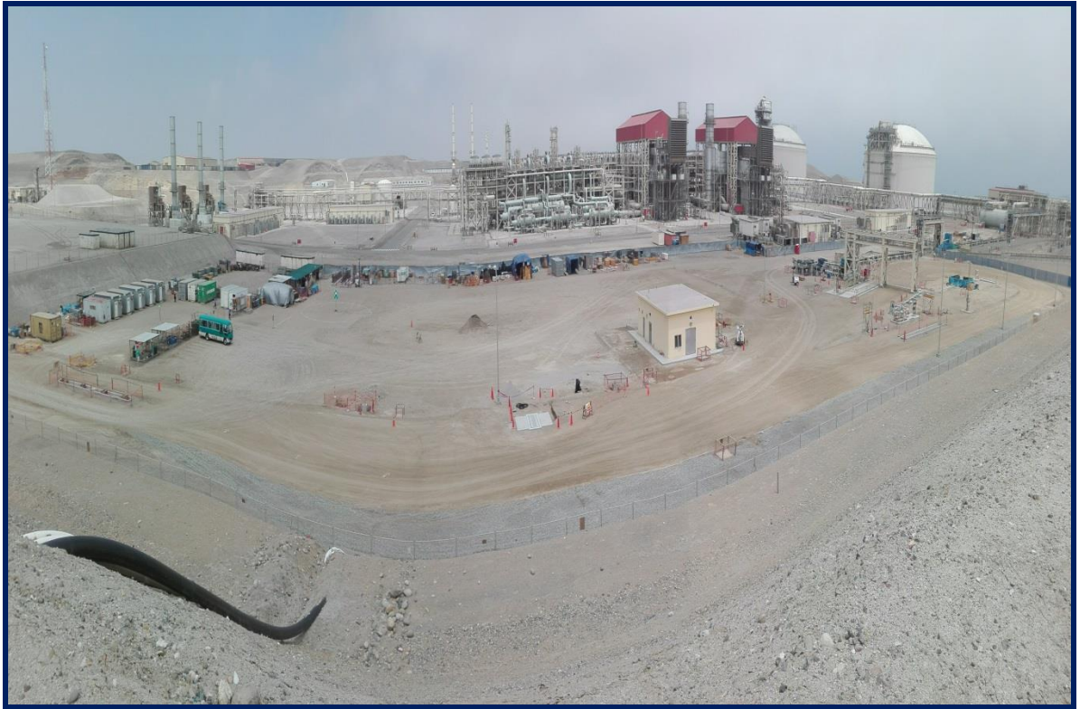
Foto 5. Vista Panorámica de la Zona de Carga de GNL
