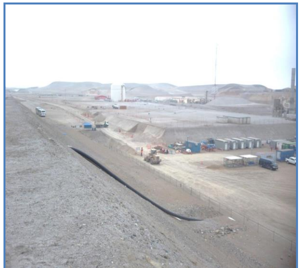
Foto 4. Vista del camino de acceso de camiones cisternas
