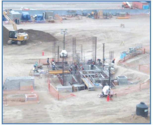
Foto 2. Vista de la construcción del cuarto de control
