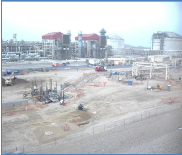
Foto 1. Vista panorámica de construcción del Cargadero de GNL
