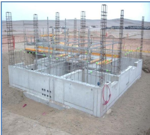
Foto 3. Cimentación del oficina de recepción de camiones cisternas
