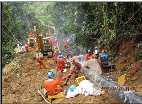
Imagen 14: Vista de las actividades de soldeo de tubos de 10'' para la habilitación del by-pass. (27.01.2016)
