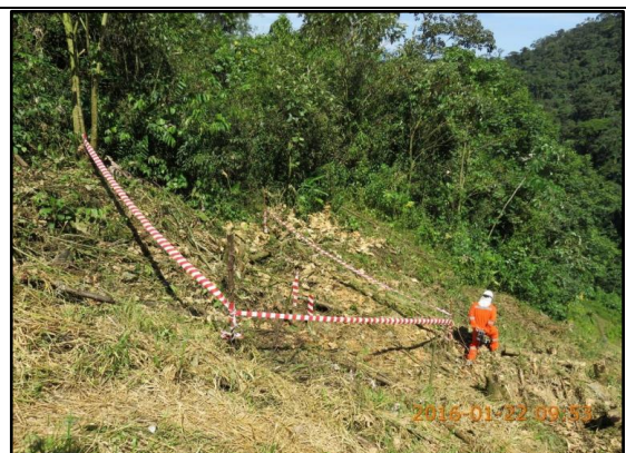
Imagen 04: KP 56+500, Probable punto de falla señalizado con cintas de seguridad. (22.01.2016)
