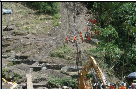
Imagen 16: Vista de personal instalando durmientes en el by pass de 10''. (02.02.2016)
