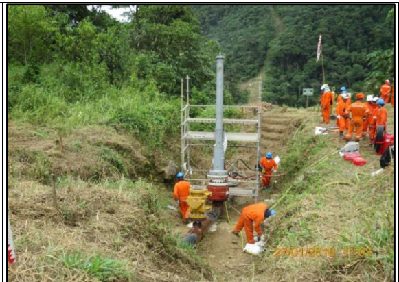
Imagen 15: KP 56+700, Vista de trabajos de instalación del stop line y válvula de 8'' (color amarillo) para la conexión del By pass de 10'' (27.01.2016)
