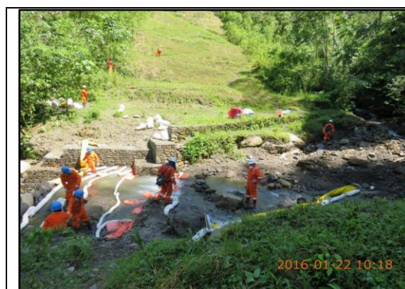
Imagen 07: KP 56+300, Vista de personal realizando trabajos de mitigación en la quebrada Igoritoshiani. (22.01.2016)
