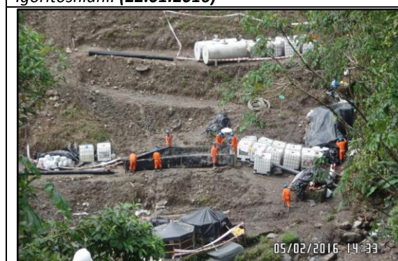
Imagen 09: KP 56+300, Vista de personal de medio ambiente realizando el recubrimiento con geomembrana a las áreas de confinamiento temporal. (05.02.2016)
