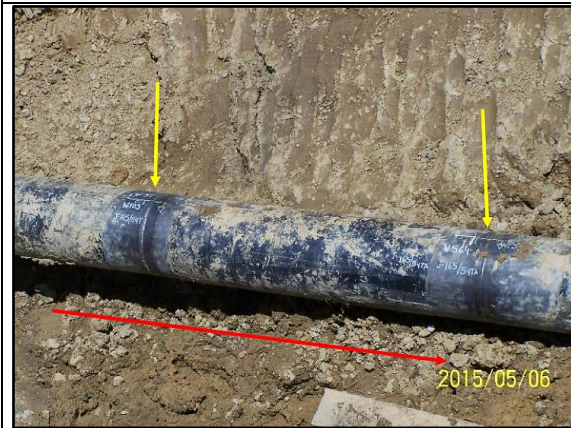
Imagen 16: Vista en la cual se aprecia el niple soldado que reemplaza el tramo de tubería que contenía la falla presentada en el ducto de LGN. (06.05.2015)
