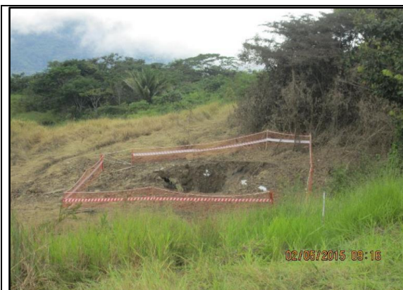
Imagen 03: KP-183+644. Vista del hoyo dentro del cual afloraba el LGN. (Diámetro aproximado 5,5 metros). (02.05.2015)
