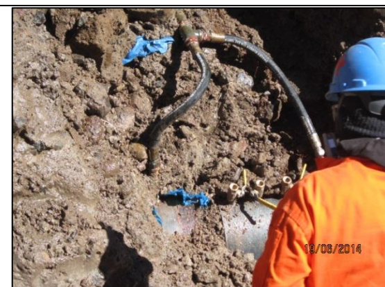
Imagen 23: Corte de la sección afectada. El niple extraído tiene una longitud de 1.10 metros (23.10.2012)
