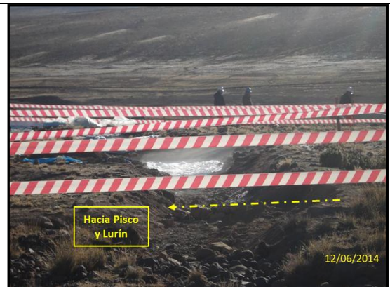
Imagen 04: Delimitación de la zona caliente (zona de seguridad), lugar de emanación de LGN. (12.06.2014)
