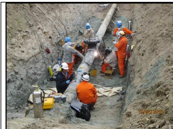
Imagen 17: Personal de TGP realiza trabajos de preparación de superficie y soldadura de Split Tee. (15.06.2014)
