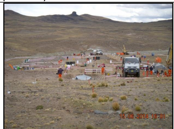
Imagen 06: Vista panorámica de los trabajos previos a la ejecución del Hot Tap y montaje del By-Pass de 10" en el STD-LGN. (15.06.2014)
