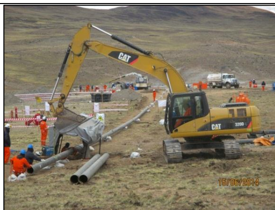
Imagen 18: Personal de TGP realiza soldadura de By-Pass de 10". (15.06.2014)
