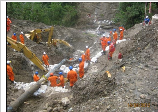
Imagen 16: Disposición de las maquinarias para el primer corte de la tubería, aguas abajo del punto de falla. (14.04.2012)
