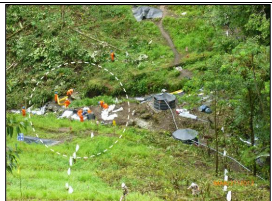
Imagen 08: KP 56+600, construcción de gaviones para encausar quebrada por donde filtra LGN. (21.03.2012)
