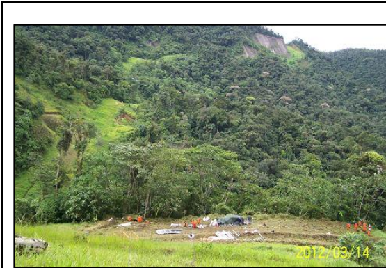
Imagen 05: KP 57+300, construcción de Campamento de Emergencia. (14.03.2012)
