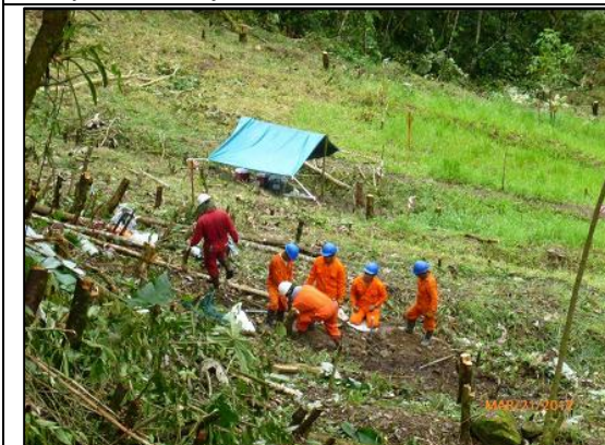
Imagen 09: KP 56+650, Cuadrilla de TGP realizando la toma de muestras de suelo para ver el grado de contaminación. (21.03.2012)
