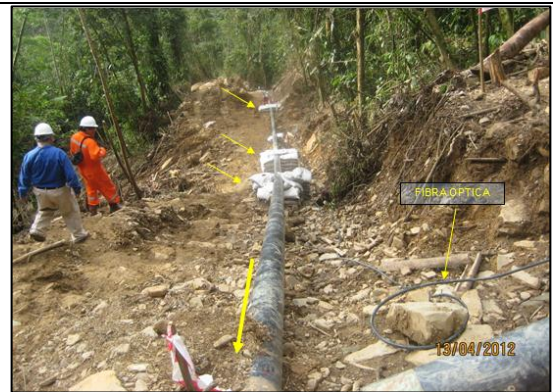
Imagen 15: Instalación del By-Pass de 8" y de la fibra óptica para no interrumpir la operación del sistema. (13.04.2012)
