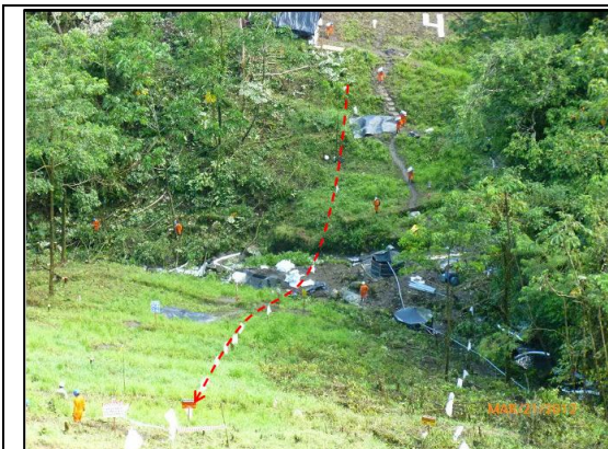
Imagen 07: KP 56+600, instalación de salchichas absorbentes (material oleofílico) en la quebrada s/n. (21.03.2012)
