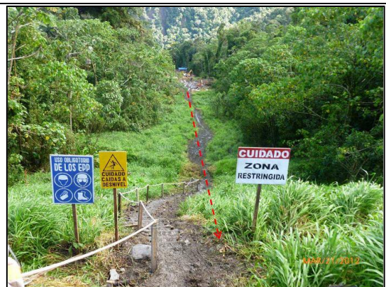
Imagen 04: KP 57+000, instalación de Letreros de seguridad para restringir el acceso a la zona del incidente. (21.03.2012)
