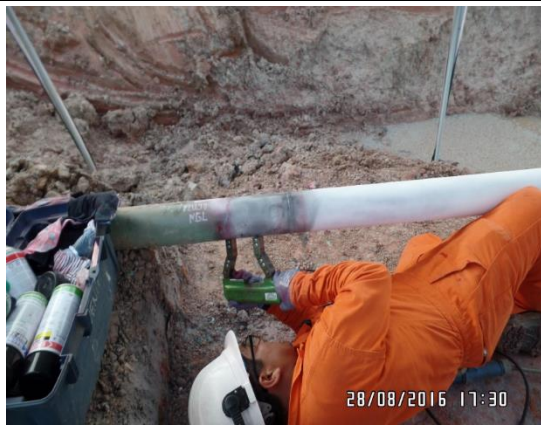
Imagen 14: Vista de la ejecución de END (partículas magnéticas) como parte de las actividades de reparación temporal del ducto de 4" de LGN en KP 81+500
