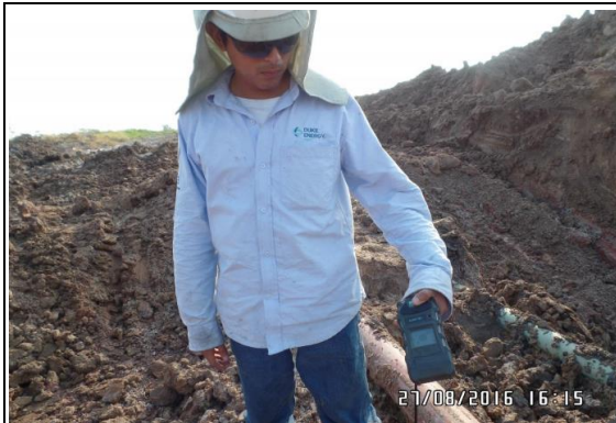
Imagen 06: Vista del monitoreo de los vapores de LGN con detector de gases. (KP 81+500).
