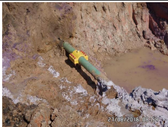
Imagen 12: Vista donde se aprecia la grampa certificada instalada en el ducto de 4" de LGN por personal de Aguaytia Energy.
