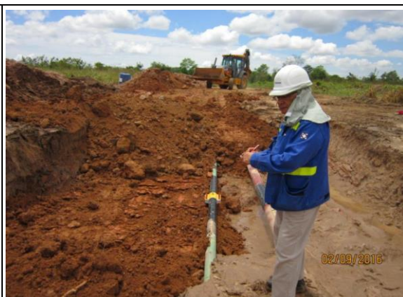
Imagen 19: Vista de supervisor de Osinergmin verificando las actividades de recuperación de tapada. (KP 81+500).
