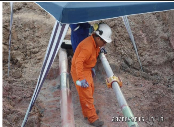
Imagen 13: Vista de la aplicación de tintas penetrantes como parte de las actividades de reparación temporal del ducto de 4" de LGN en KP 81+500
