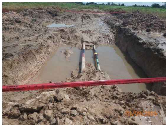
Imagen 15: Vista panorámica de la reparación temporal el cual consistió en la instalación de una grampa envolvente de acero al carbono de 4" (en la imagen se muestra el recubrimiento epóxico anticorrosivo aplicado) en KP 81+500
