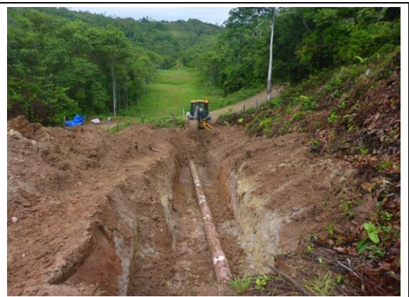
Imagen 03: Actividades de acondicionamiento (Apertura de Zanja y Remoción de material) para la reparación de la falla ocurrida en el KP 40+000 del ducto de 10" de GN. (Fuente Aguaytía)
