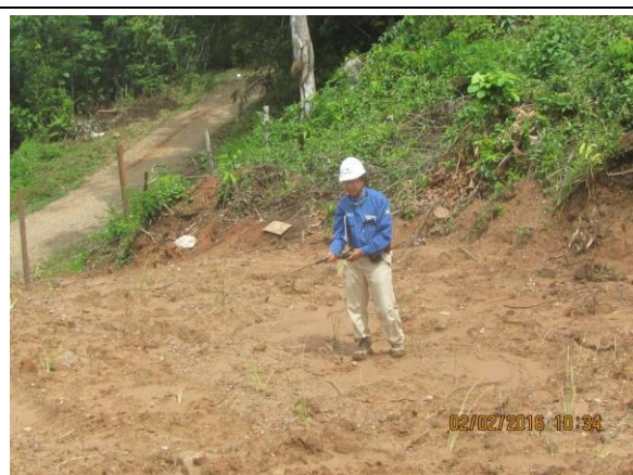
Imagen 17: Vista de supervisor de Osinergmin verificando el nivel de tapada en el punto de la falla. (KP 40+000).
