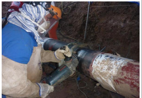
Imagen 09: Vista del esmerilado del segundo cordón de soldadura (Fuente Aguaytia)
