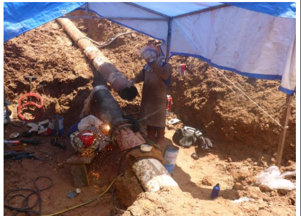
Imagen 07: Vista de la ejecución de la soldadura del niple de remplazo (Fuente Aguaytia)
