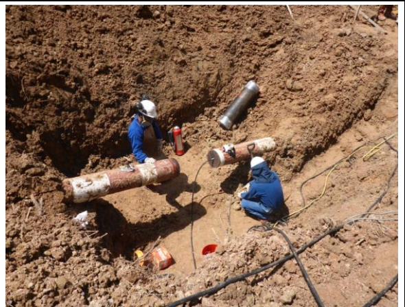
Imagen 05: Vista de la inyección de nitrógeno para la inertización del tramo de tubería a intervenir. (Fuente Aguaytia)
