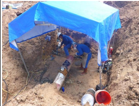
Imagen 06: Vista de las actividades de biselado y alineamiento, previas a la soldadura del niple de remplazo (Fuente Aguaytia)
