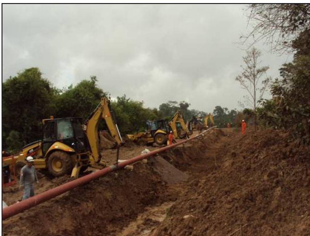
FOTO N° 06: KP 36+928, bajada de tubería en zona afectada.
