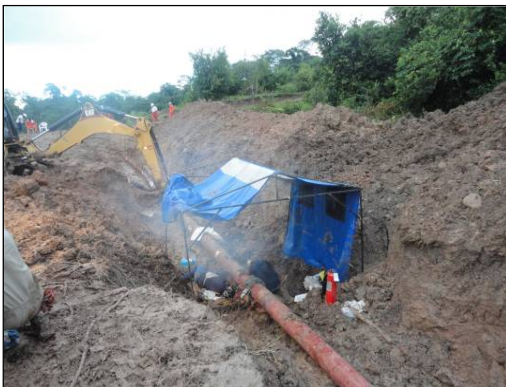
FOTO N° 07: KP 36+928, Soldeo de empalme de tubería.
