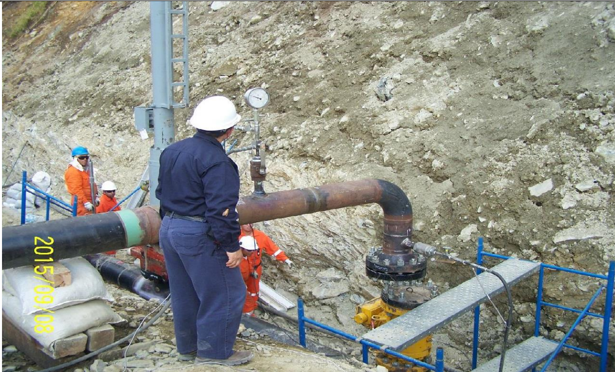
Figura 08: Vista de prueba hidraulica al by pass del ducto de LGN.
