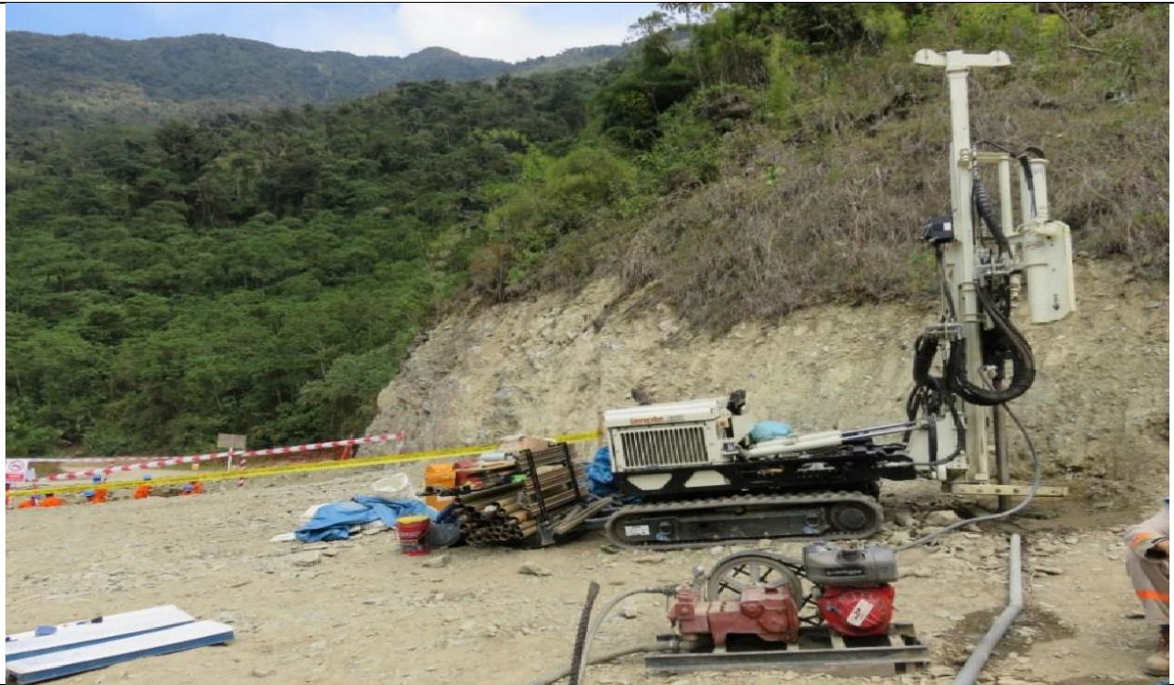
Figura 12: Vista de los trabajos de investigación geotécnica mediante sondajes profundos.
