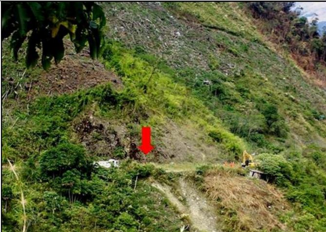
Figura 02: Vista del punto donde se detectó una anomalía (arruga) en los ductos de GN y LGN.
