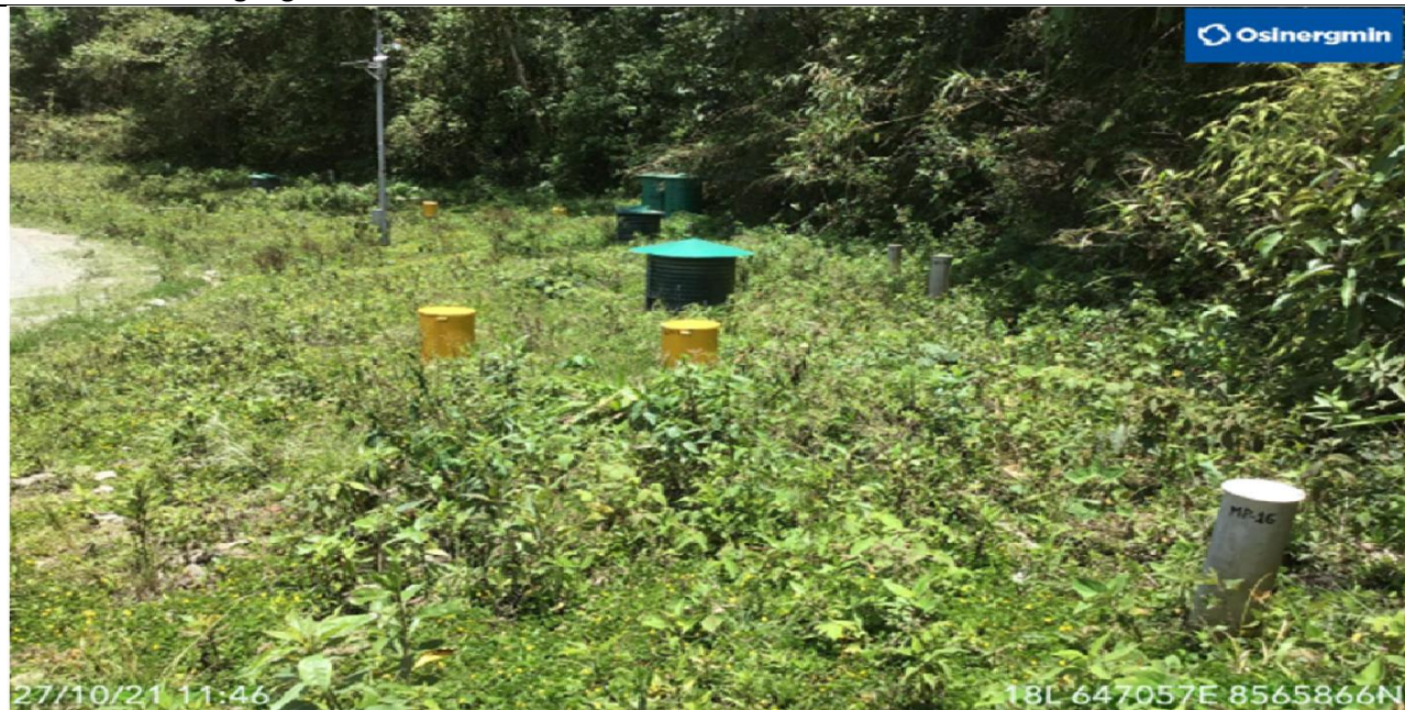
Figura 16: Vista del DDV a la altura del KP 196+633, se verifica tramo estable instrumentación geotécnica (Inclinómetros piezómetros) y Strain Gauges. (Fecha: 27.10.2021)
