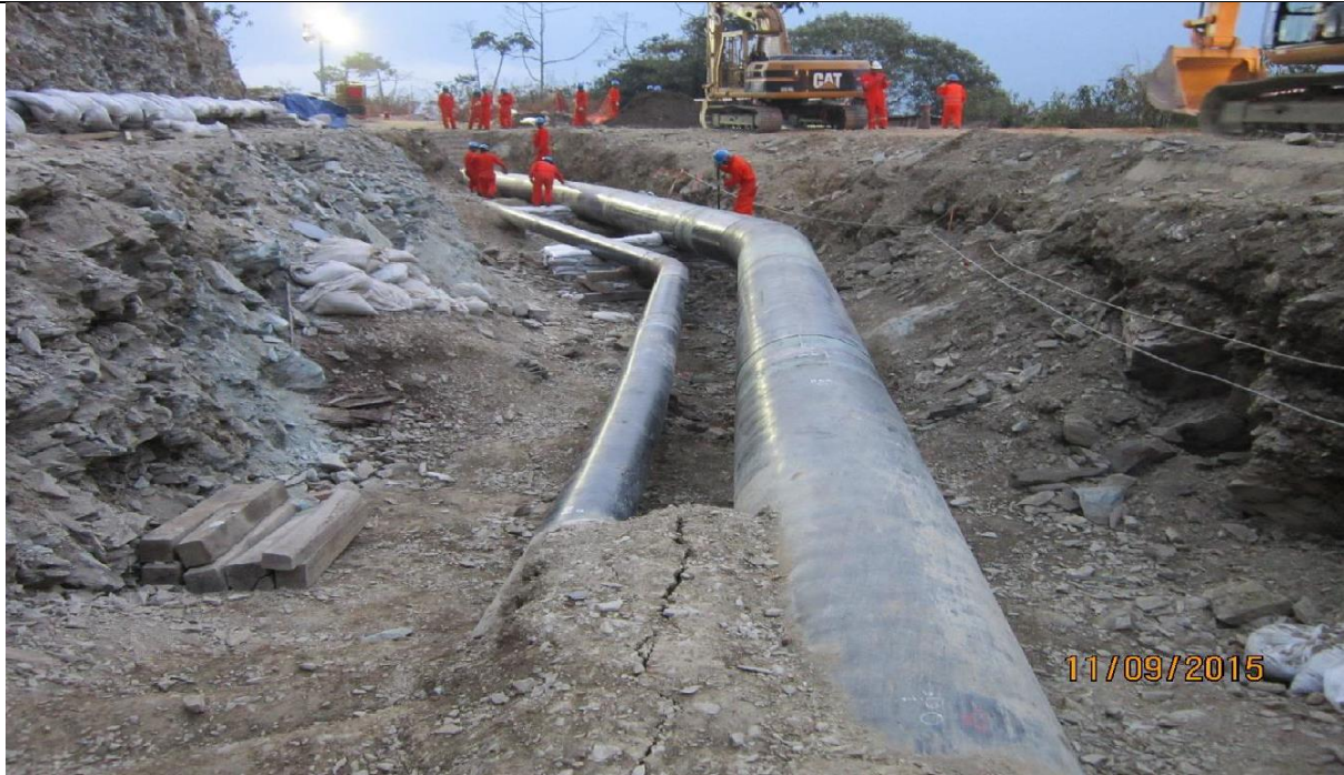
Figura 11: Vista de segmento de los ductos de LGN y GN reemplazados.
