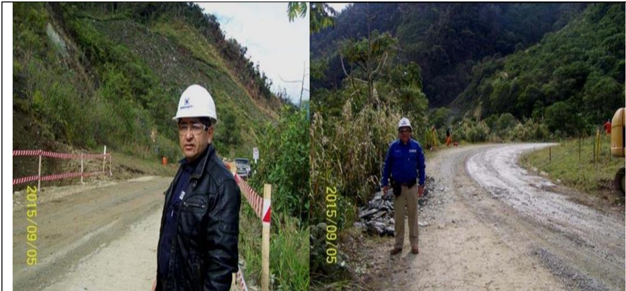
Figura 04: Vista de representantes de Osinergmin en la zona donde se detectó una anomalía en los ductos de GN y LGN.
