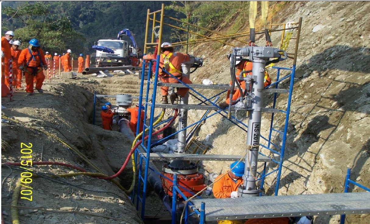
Figura 07: Instalación de hot tap en el ducto de LGN.
