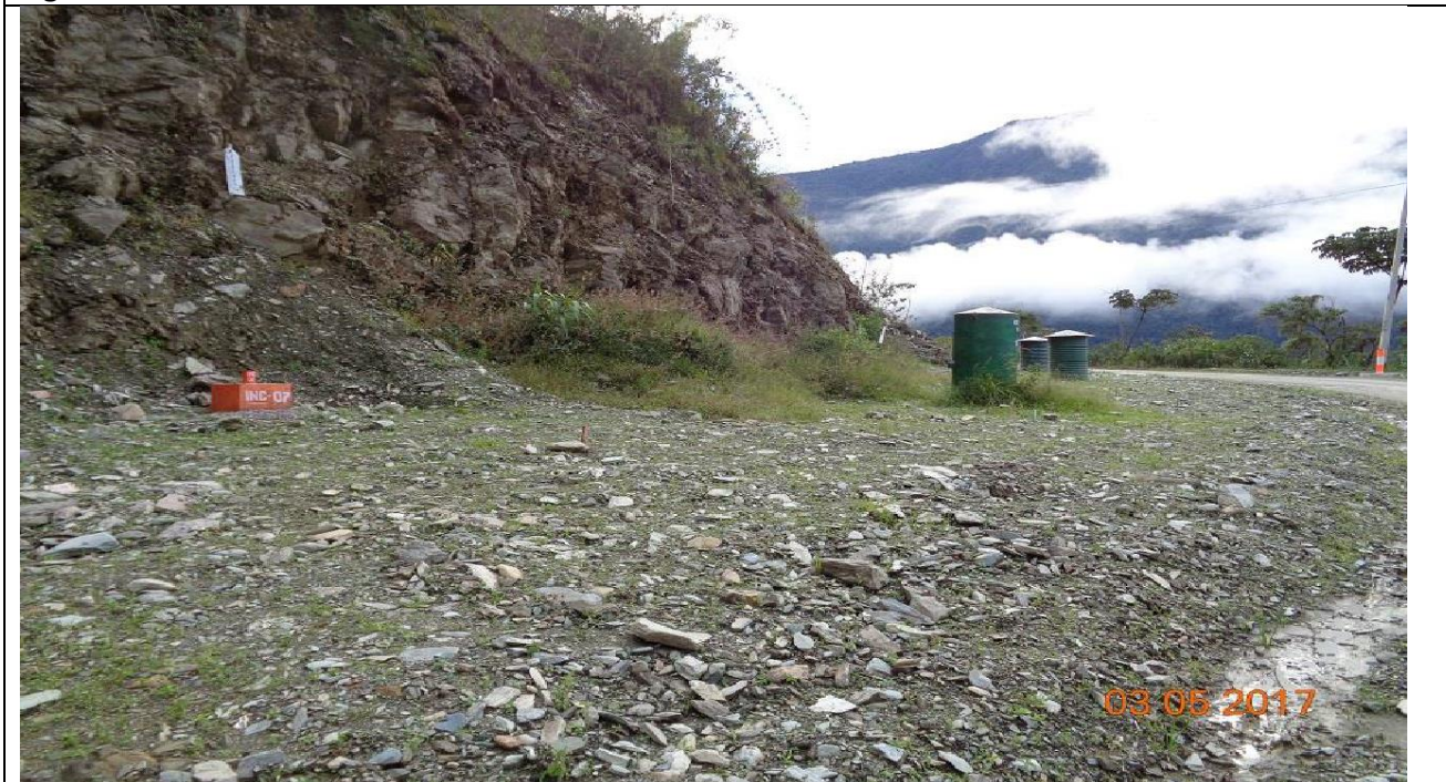
Figura 14: Vista panorámica de la instrumentación instalada a la altura del KP 196+633, inclinómetros y casetas de strain gauge.
