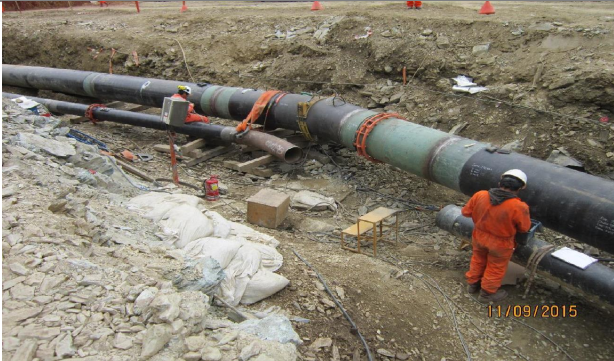
Figura 10: Vista de segmento del ducto de GN reemplazado.
