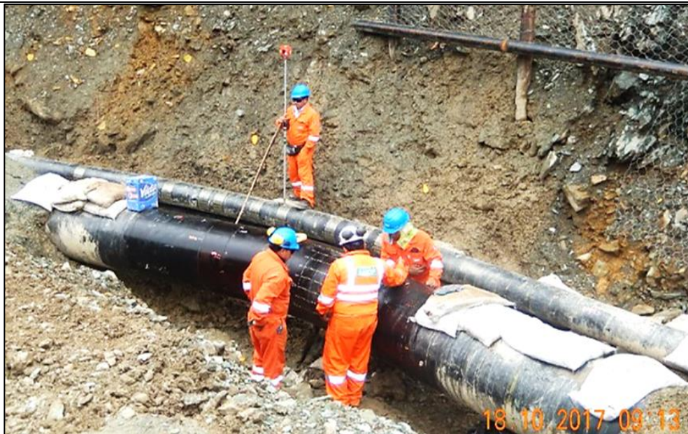
Figura 04: KP 196+581, Inspección y Evaluación del ducto de GN y ejecución de mediciones topográficas.
