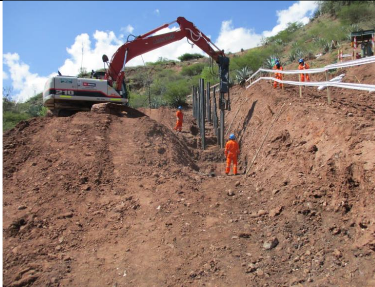
Figura 03: KP 244+100 – Hincado de pilotes. Diciembre de 2019. Fuente: TGP
