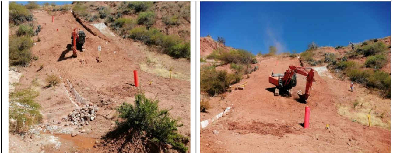
Figura 06: KP 243+900 – Vista panorámica de los trabajos de relleno y recomposición del DDV. Fuente: Informe de Integridad actualizado a noviembre 2021.
