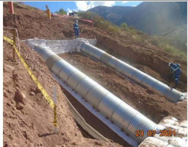
Figura 05: KP 243+900 – Liberación de tensiones. Fuente: Informe de Integridad actualizado a noviembre 2021.
