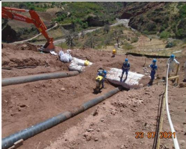
Figura 05: KP 243+900 – Liberación de tensiones. Fuente: Informe de Integridad actualizado a noviembre 2021.
