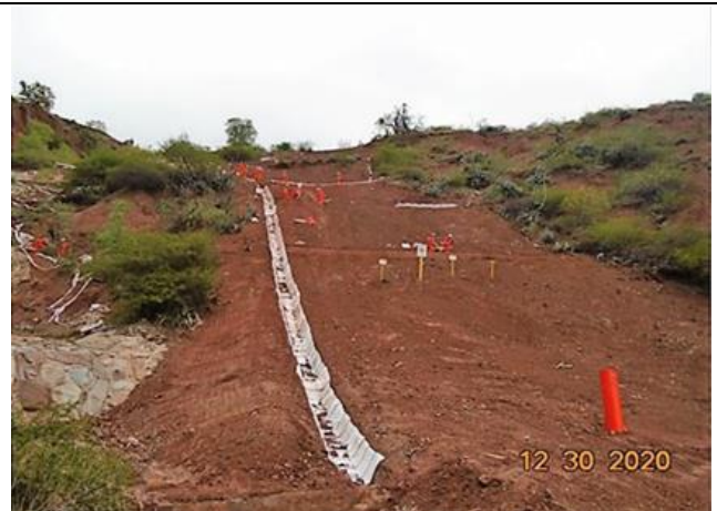
Figura 04: KP 244+100 – Ensayo no destructivos – medición de espesores y revestimiento de cortacorrientes y canal colector en el KP 243+600. Fuente: TGP
