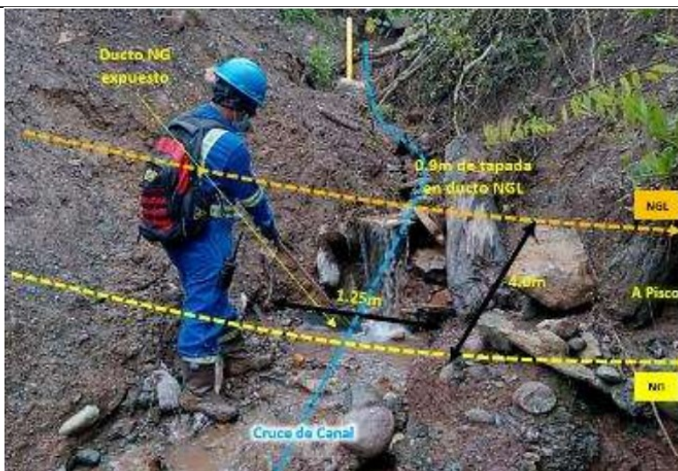
Figura 02: Exposición del ducto de GN a la altura del KP 187+540, como consecuencia de un proceso erosivo en la quebrada que cruza el DDV.
