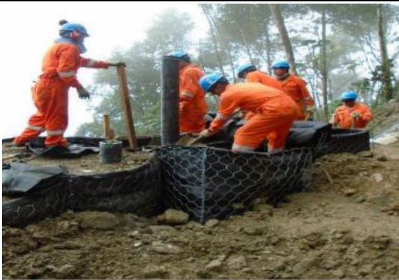
Figura 04: Construcción de muros de gavión de bolsas ACEbags y relleno de talud con material de préstamo. Fuente: TGP
