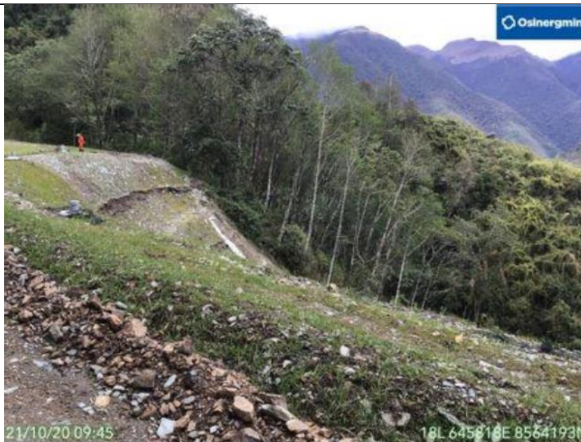
Figura 08: KP 199+800 – Verificación de los trabajos culminados en el talud inferior del lado derecho de la sección de la carretera San Antonio – San Miguel que comparte con el DDV.
