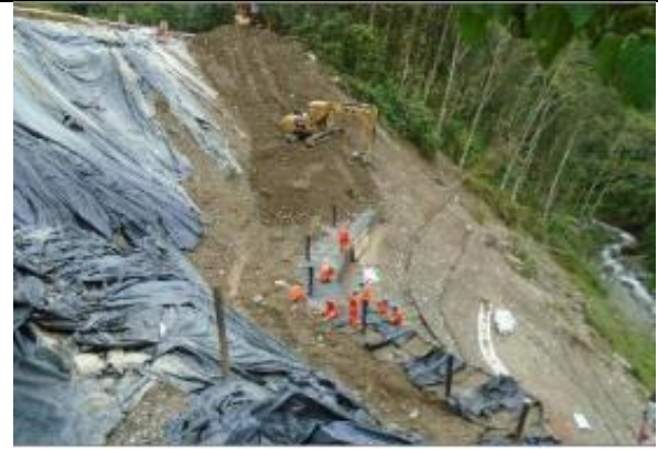
Figura 04: Construcción de muros de gavión de bolsas ACEbags y relleno de talud con material de préstamo. Fuente: TGP
