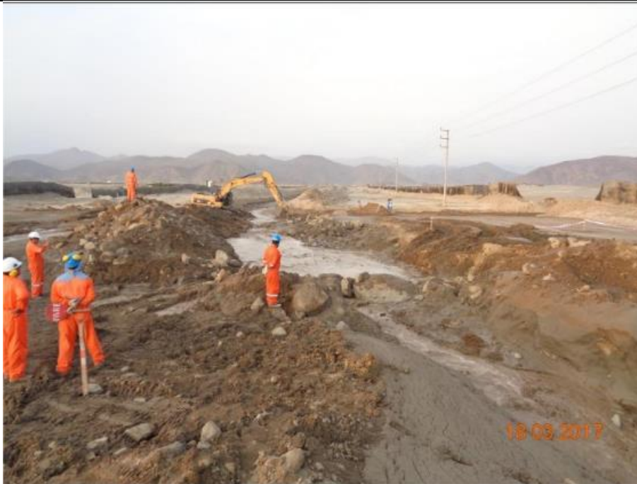
Figura 03: KP 726+140 - Vista de la implementación de sedimentador con piedra de sobre tamaño que se ejecuta aguas arriba del cruce de quebrada Rio Seco.
