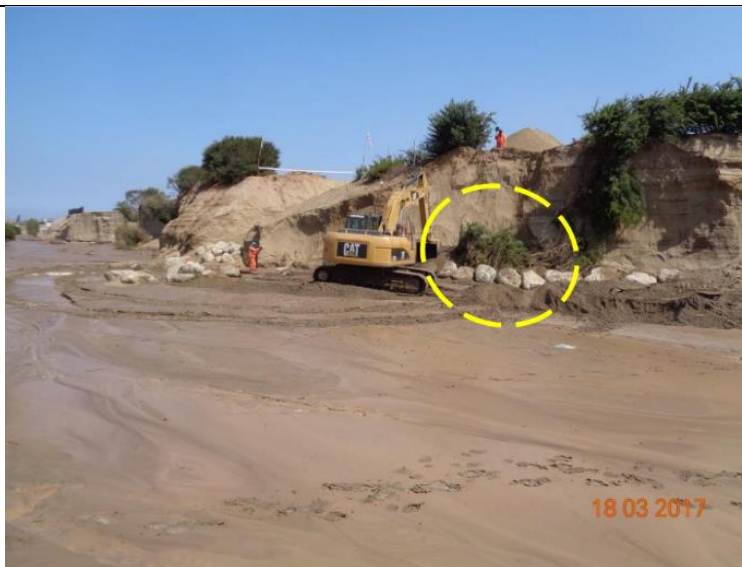
Figura 03: KP 703+940 – Verificación de los trabajos de enrocado en la margen derecha de cruce subfluvial y la recuperación de tapada de los ductos de 18” y 24” GN.
