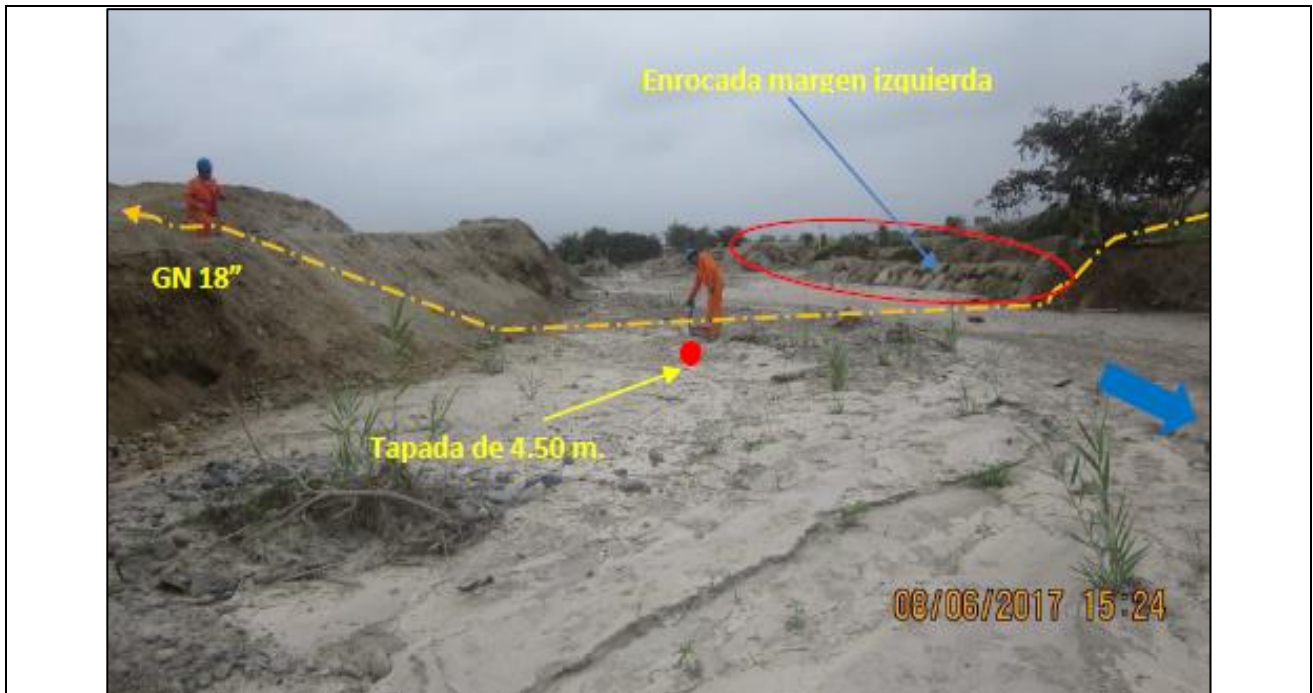
Figura 04: KP 659+649, cruce subfluvial de los ductos de 18" y 24" GN, en el cual se evidenció la medición de tapada del ducto de 18" de diámetro.
