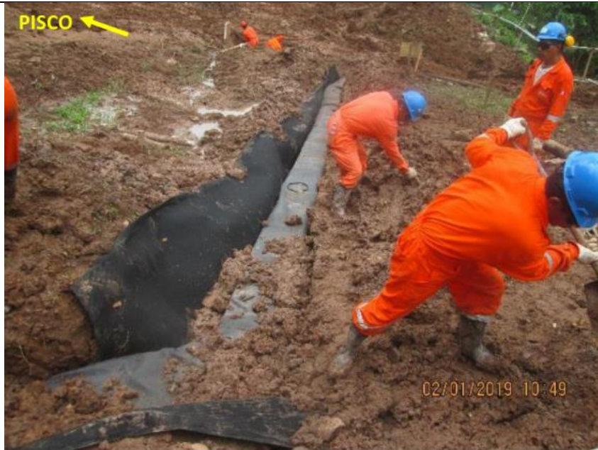
Figura 03: Sellado de grietas e instalación de filtros drenantes en la zona afectada del DDV. Fuente: TGP
