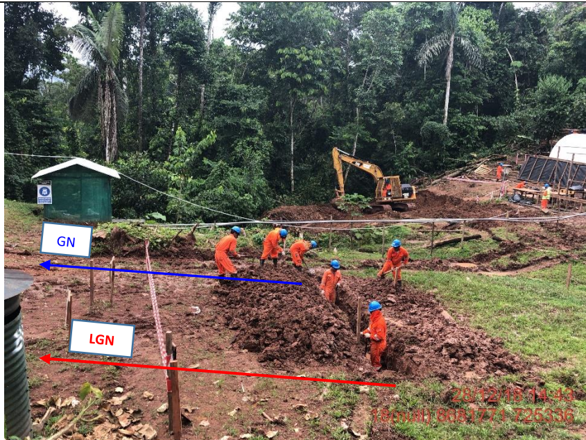
Figura 04: KP 008+400, verificación de la demarcación de la zona de grietas y de los trabajos preliminares en el DDV para el sellado de grietas e implementación de obras de geotecnia.
