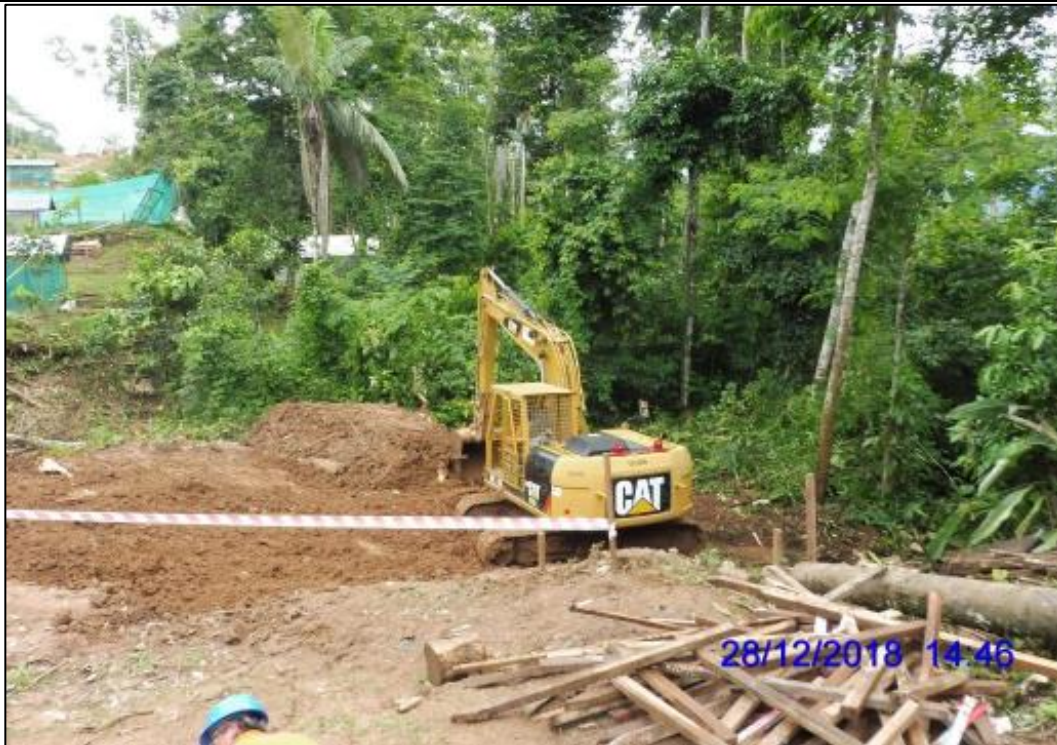
Figura 07: KP 008+400, verificación de trabajos mecánicos para el perfilado y sellado de grietas en el DDV.
