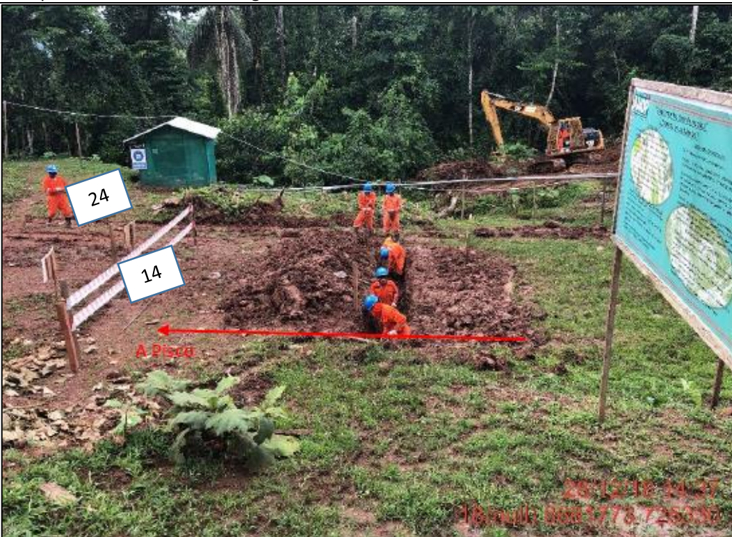
Figura 05: KP 008+400, excavación de zanja para la colocación de filtro tubo geodren de 4" de diámetro.
