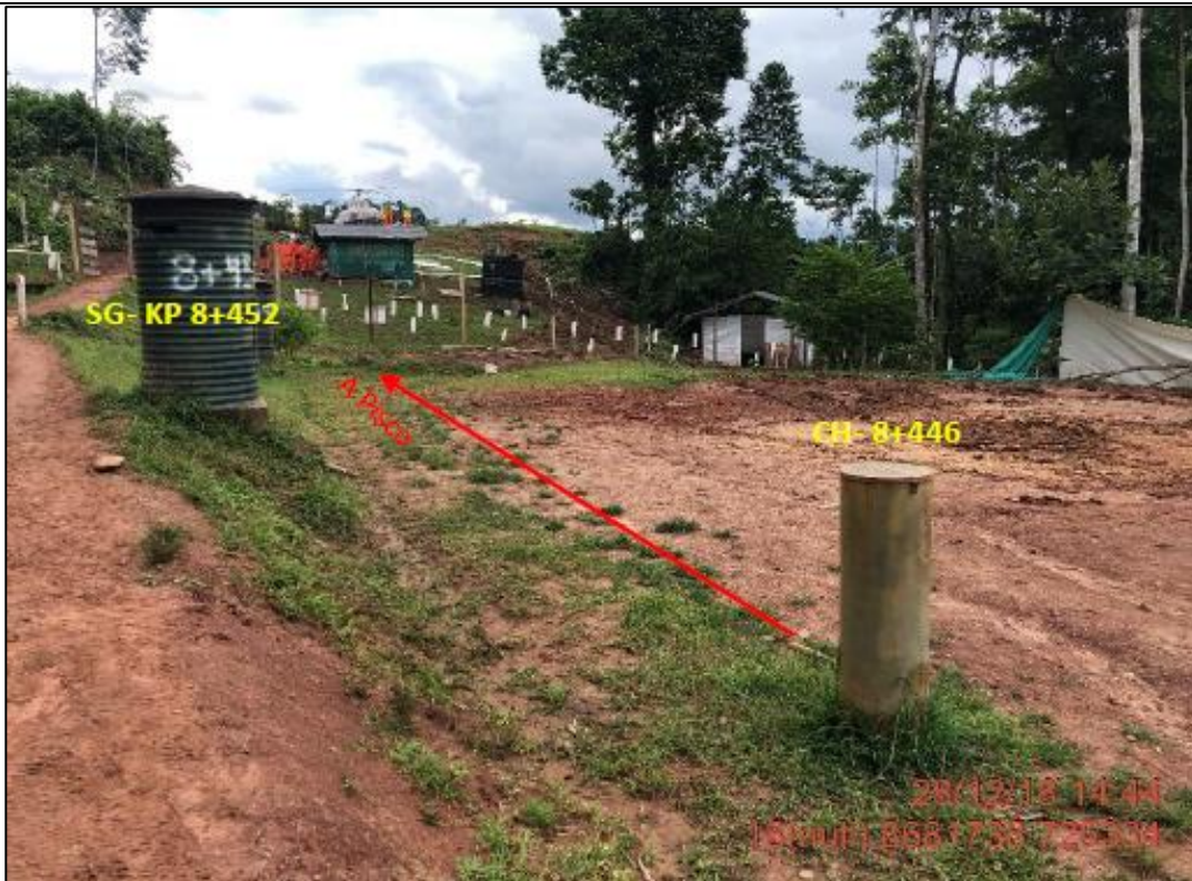
Figura 08: KP 008+400, verificación de las estaciones de strain – gauge y chimenea, cerca al área donde se produjeron las gritas de tracción. Las lecturas mostradas por el supervisor de geotecnia de TGP indicaron valores normales dentro del rango de seguridad.
