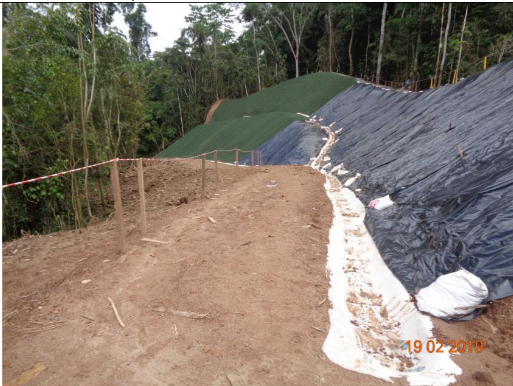
Figura 13: KP-8+400 del DDV de TGP / (WGS84, 18L 725289E 8681796N). Exterior del lado derecho del DDV, se aprecia los trabajos de perfilado del talud y conformación de terraplén. Se protege el talud con Macmat R y plástico agropol, se realizan obras de control de escorrentía. (fuente IS-0001003292-CEG-JAB)
