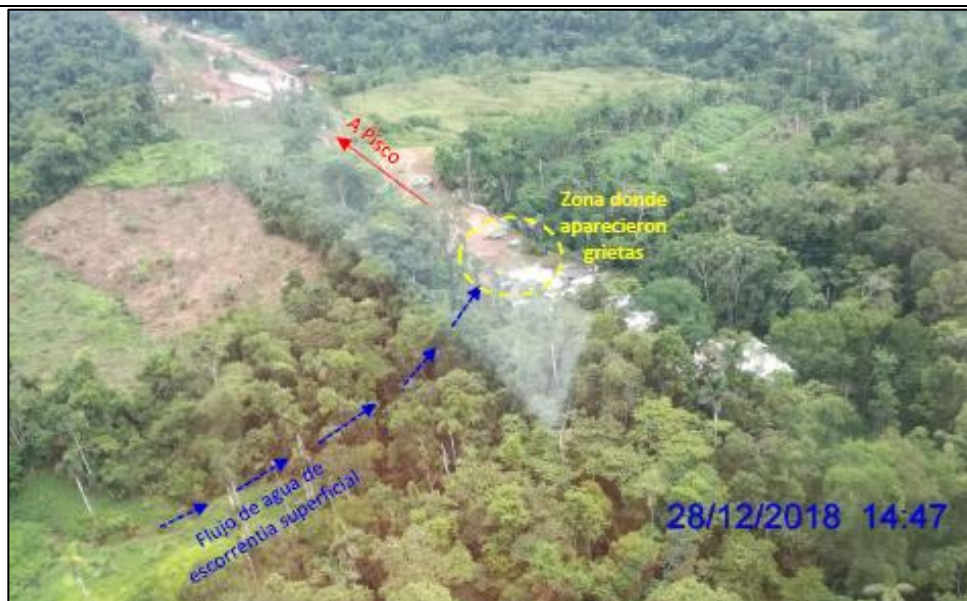
Figura 03: KP 008+400, vista aérea de la parte superior del DDV, donde se aprecia un curso natural de aguas superficiales que se activan en la temporada de lluvias, ocasionando la saturación de los suelos.
