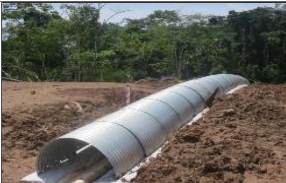
Figura 05: KP 008+900, instalación de alcantarilla para proteger la tubería flexible en zona de by-pass Fuente TGP.
