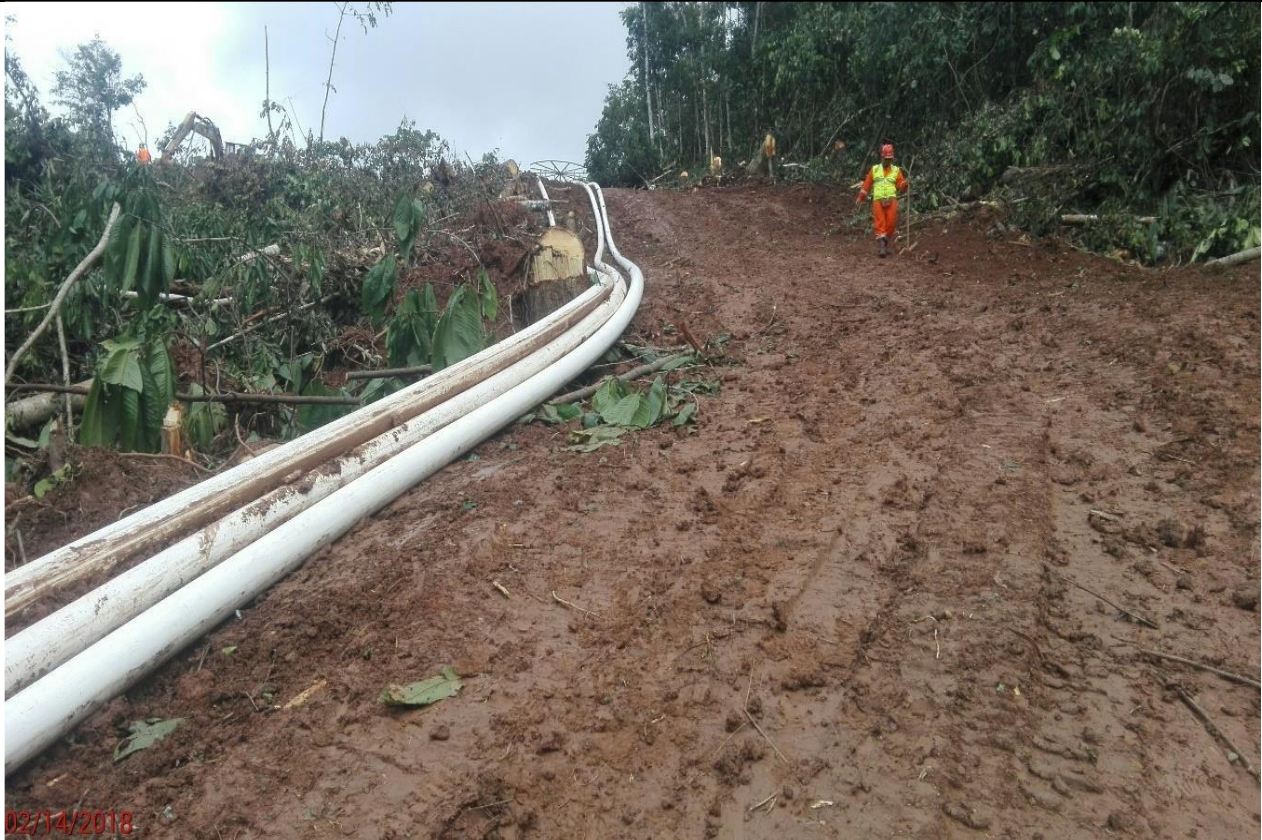
Figura 11: Bypass Temporal. Tendido de tres líneas de tubería flexible 6" a lo largo de la variante.
