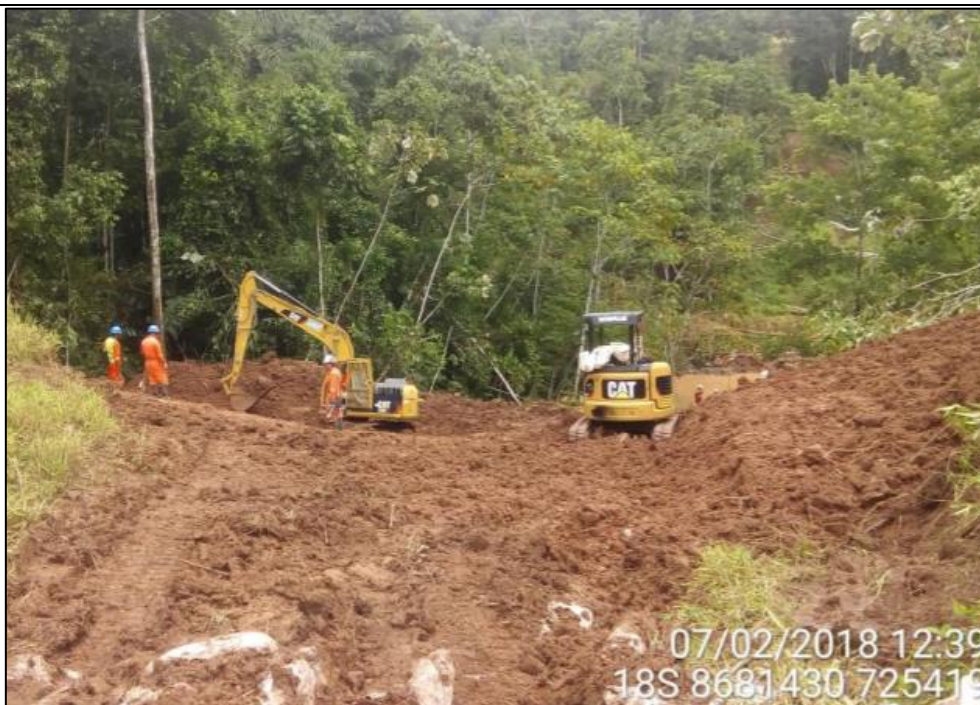
Figura 03: KP 008+900, trabajos de remoción de terreno en la zona donde se detectó la condición de riesgo
