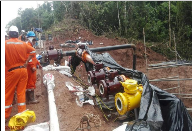
Figura 09: Bypass Temporal. Detalle de la instalación del Spool, Manifold y Válvulas (Lado Malvinas)
