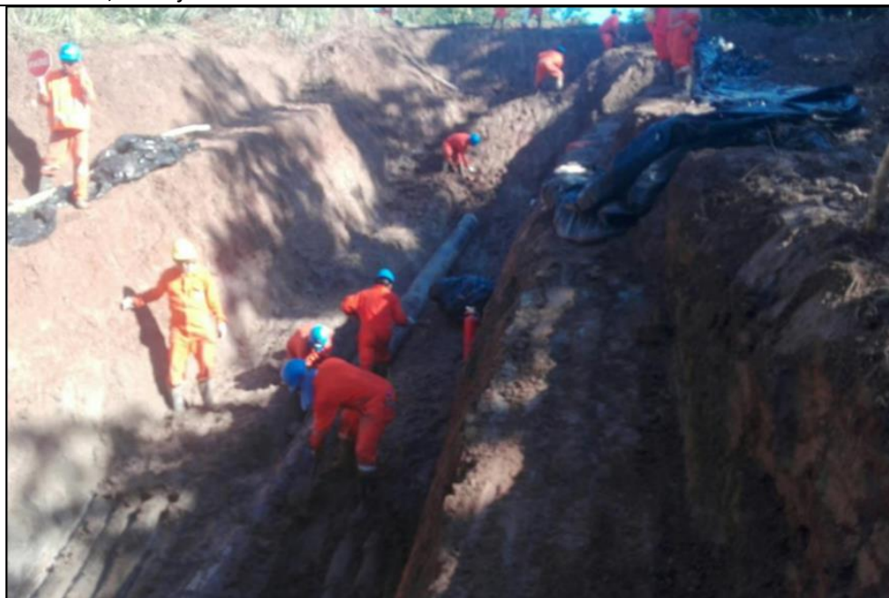
Figura 04: KP 008+900, trabajos de excavación
