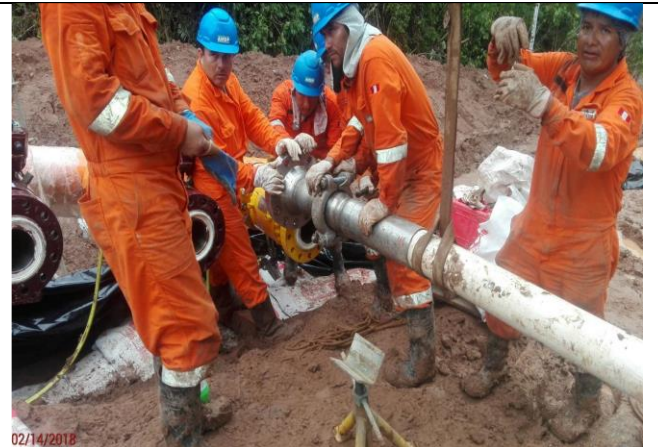
Figura 10: Bypass Temporal. Instalación y montaje de la tubería flexible (Lado Malvinas).
