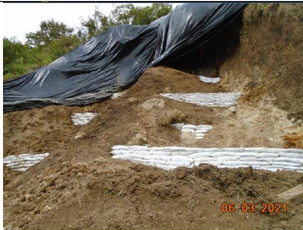
Figura 04: Instalación de barreras de contención en la zona del deslizamiento y actividades de recomposición del DDV con maquinaria. Fuente: TGP
