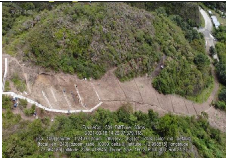
Figura 04: Vista aérea de los trabajos de manejo de aguas superficiales, recomposición y revegetación en el DDV. Fuente: TGP
