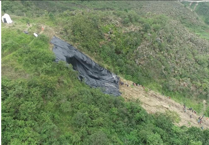
Figura 06: Vista aérea tomada con dron en el sobrevuelo del KP 202+099, donde se verifica la protección de la zona afectada por un deslizamiento que originó el flujo de tierra sobre el DDV.
