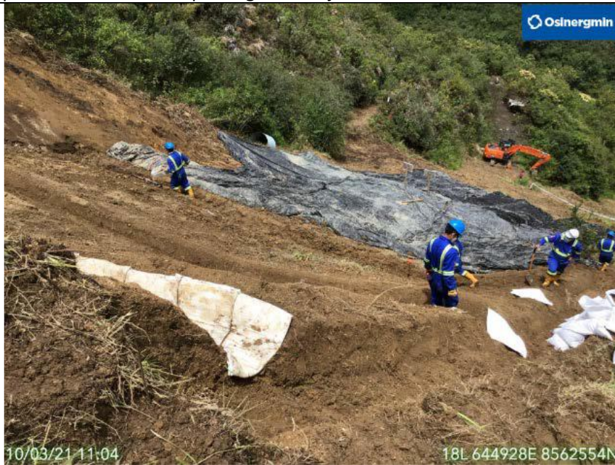
Figura 07: Vista del KP 202+099, con ejecución de trabajos de re conformación y recomposición del DDV, con construcción de cortacorrientes transversales, en tramo con riesgo por deslizamiento de detritos.
