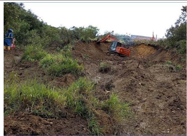
Figura 04: Instalación de barreras de contención en la zona del deslizamiento y actividades de recomposición del DDV con maquinaria. Fuente: TGP
