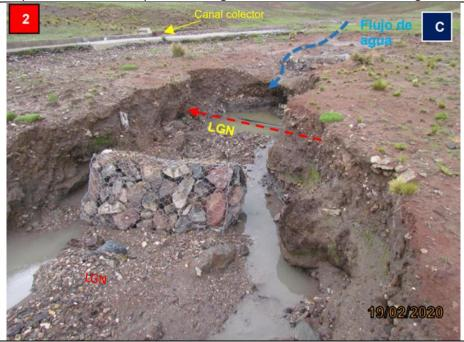
**Figura 05:** KP 415+085, Vista de quebrada con canal colector que rebosó el caudal hacia la margen izquierda, ocasionando la socavación y cárcava de 8.0 m de longitud, producida por escorrentía superficial de agua desde el canal colector contiguo.
