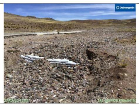
**Figura 06:** KP 415+085, se aprecian los trabajos de recuperación de tapada y reconformación de terreno del DDV, zona que fue afectada por socavación debido al desborde, aguas arriba, de la escorrentía superficial de la quebrada.
