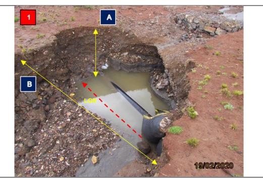
**Figura 04:** KP 415+085, socavación del DDV ocasionando una cárcava de 1.85 m de profundidad y 3.3. m. de ancho, producida por la escorrentía superficial de agua desde el canal colector contiguo
