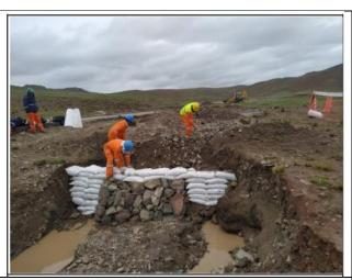
**Figura 03:** KP 415+085 — Acciones realizadas por el agente supervisado para la recuperación de tapada y reconformación de terreno. Fuente: TGP
