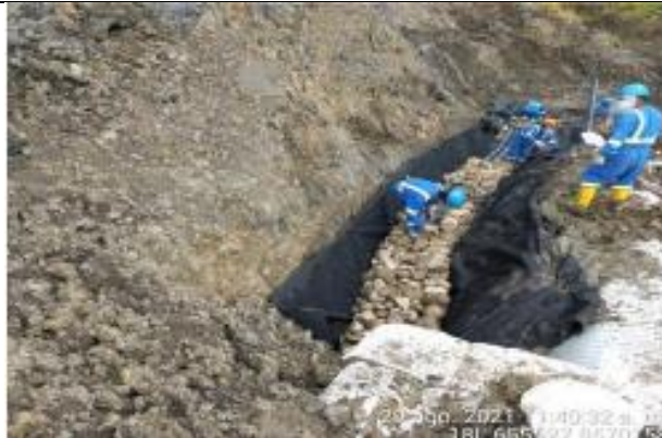
Figura 06: Finalización los trabajos de trinchera drenante y reconformación y perfilado del DDV. Fuente: Informe de Integridad KP 184+000 – actualización setiembre 2021
