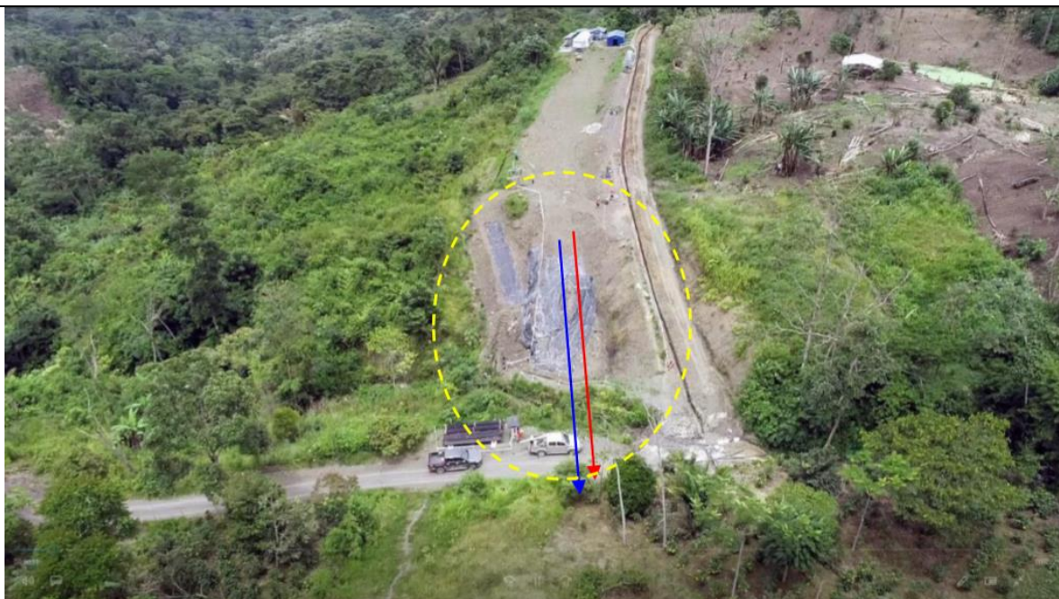
Figura 06: Vista aérea realizada por Drone, donde se aprecia el área reportado como condición de riesgo en el KP 184+000, la ladera superior se encuentra deforestada y facilita a la inestabilidad del terreno
