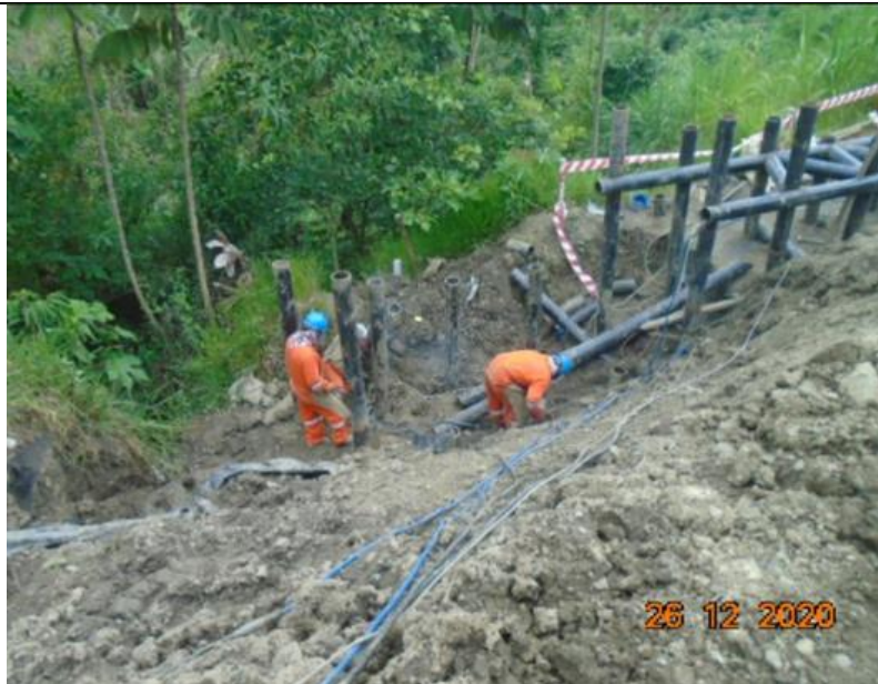
Figura 03: Trabajos de arriostramiento de pilotes de las estructuras de cimentación profunda. Fuente: COG001GAGEIT0219 - Informe de Integridad KP 184+000 enero 2021
