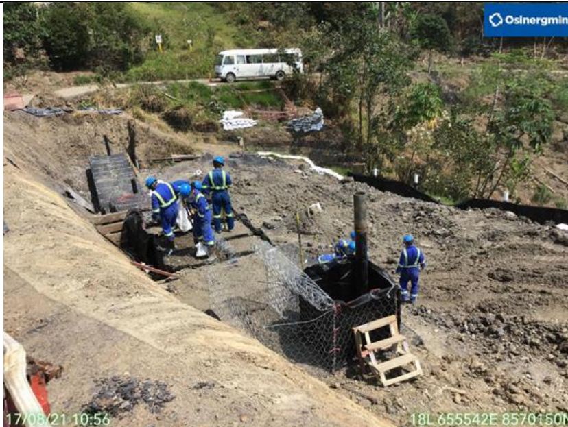
Figura 09: Verificación de trabajos de cimentación profunda mediante pilotes metálicos y la construcción de muros de contención mediante gaviones ACEbag (geobolsas) en la margen derecha del DdV
