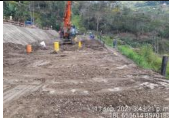
Figura 06: Finalización los trabajos de trinchera drenante y reconformación y perfilado del DDV. Fuente: Informe de Integridad KP 184+000 – actualización setiembre 2021
