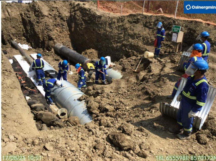
Figura 08: Verificación de trabajos de liberación de tensiones y la instalación de media alcantarillas sobre los ductos de gas natural y líquidos de gas natural.
