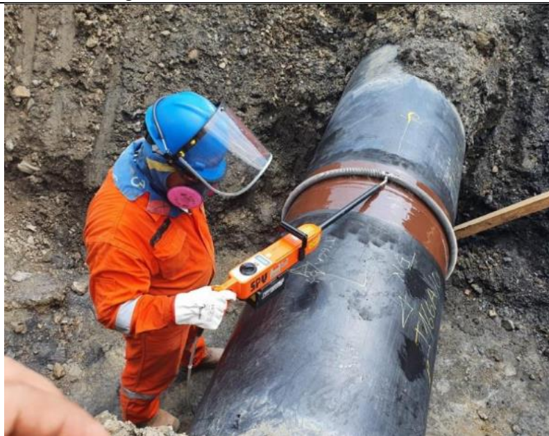
Figura 04: Ensayos No Destructivos. Inspección con equipo Holiday. Fuente: COG001GAGEIT0219 - Informe de Integridad KP 184+000 enero 2021
