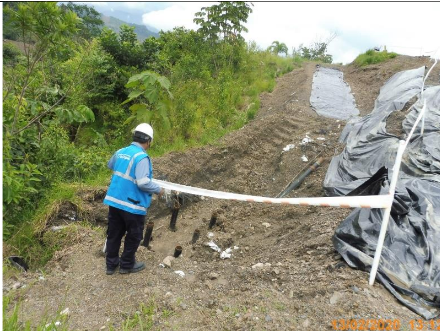
Figura 07: Verificación de trabajos parcialmente ejecutados como el hincado de pilotes metálicos en la parte inferior del DDV próxima al cruce de curso de agua y la protección del DDV con plástico.
